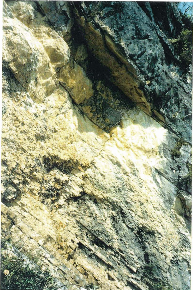
Niche d'arrachement du 03.01.94 avec de gros bancs en surplomb
