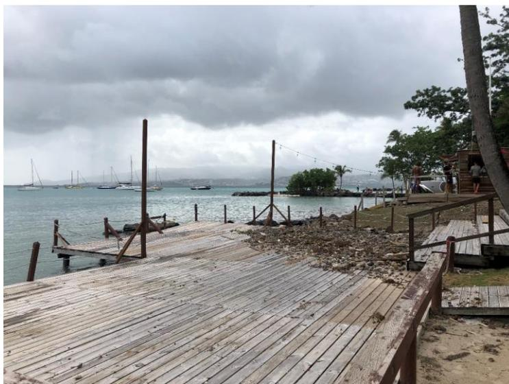
Figure 23 : Projection sur le ponton en bois de l'hôtel Bakoua (photographie 02/07/24 ©BRGM)
