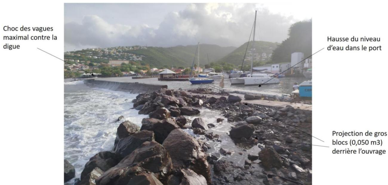
Figure 28 : Vue vers le bourg depuis la digue de Case Pilote, dégâts visibles provoqués par les vagues les plus énergétiques (WP206, photographie 02/07/24 © BRGM)
