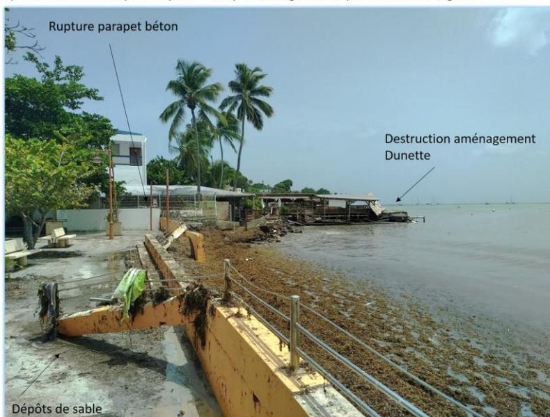
Figure 14 : Impact de la houle et dépôt de sargasses sur le centre-bourg de Sainte-Anne, photographie durant la matinée 2 juillet 2024 © BRGM
