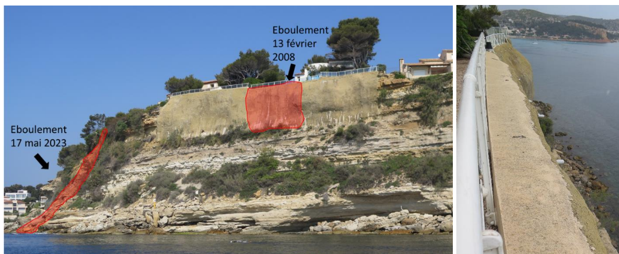
Illustration 16 : Béton projeté sur l'éboulement du 13 février 2008 à l'Est de l'éboulement du 17 mai 2023 (et vue depuis le dessus, en direction de l'Est, depuis la parcelle AX92).
