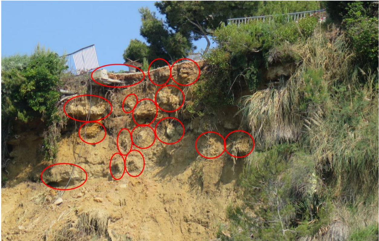
Illustration 20 : Mise en évidence d'éperons rocheux en surplomb suite à l'éboulement et considérés comme un risque résiduel.
