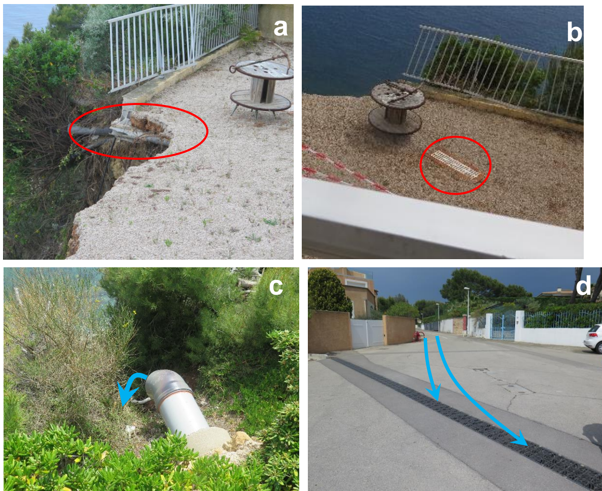
Illustration 14 : a : sortie d'évacuations au-dessus de la falaise parcelle AX92, b : regard à proximité de la falaise parcelle AX92, c : sortie de canalisation des eaux pluviales sur parcelle AX93 et d : illustration de la voirie en amont des deux parcelles AX92 et AX93 drainant toute les eaux pluviales qui arrivent dans la canalisation.
