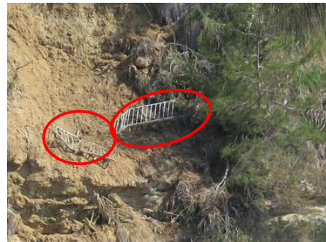
Illustration 15 : Dommages visibles avec chute de la balustrade.
