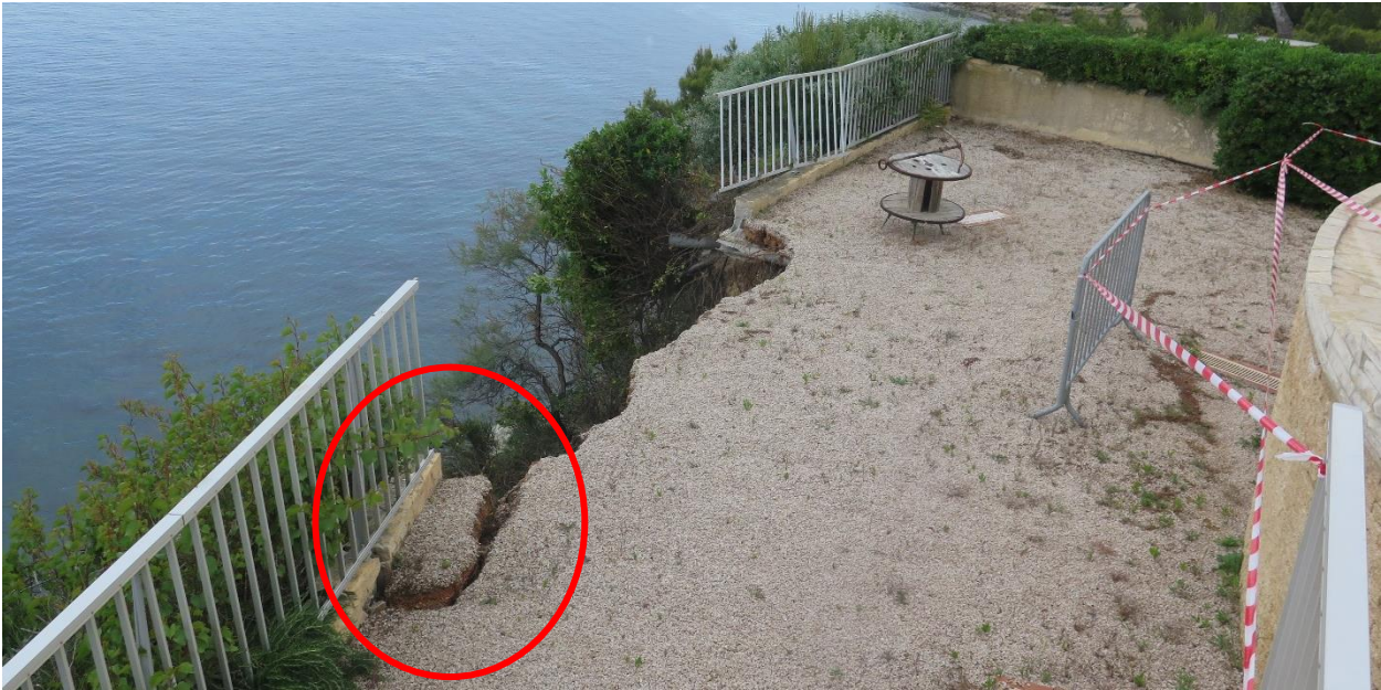
Illustration 21 : Mise en évidence d'éperons rocheux en surplomb suite à l'éboulement considérés comme un risque résiduel.
