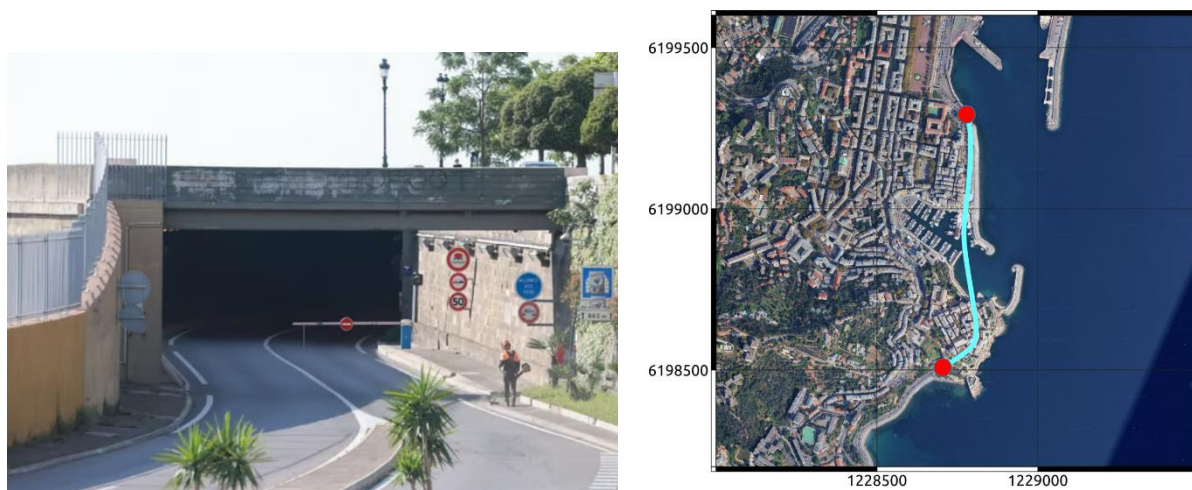
Figure 47 : A gauche, image de l'entrée du tunnel du Vieux Port de Bastia. A droite, en bleu claire son parcours.
