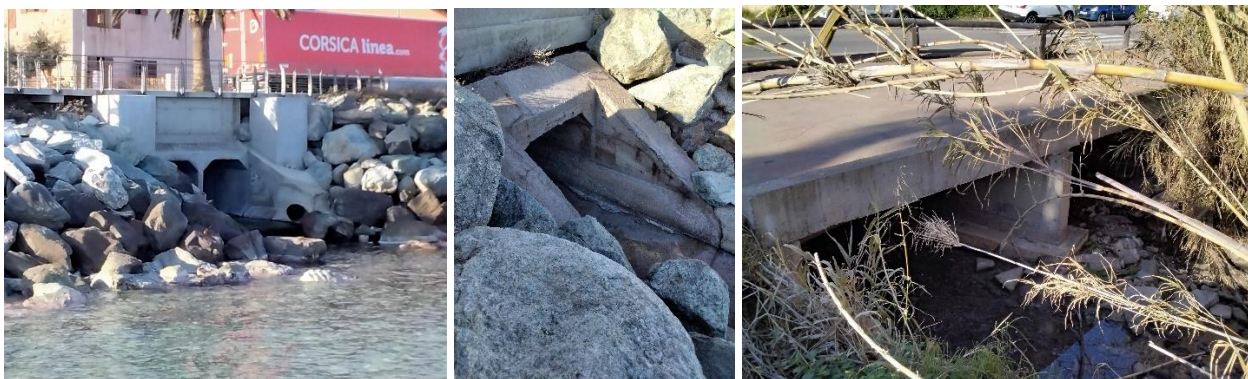
Figure 40 : Exemples de connexions hydrauliques sur la route territoriale T11 à Bastia.
