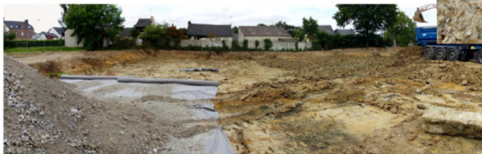
Illustration 47 : Point d'observation Cart14 – Décapage pour l'aménagement d'une parcelle située au-dessus des argiles éo-oligocènes dans le bourg de Pont-Péan (35).
