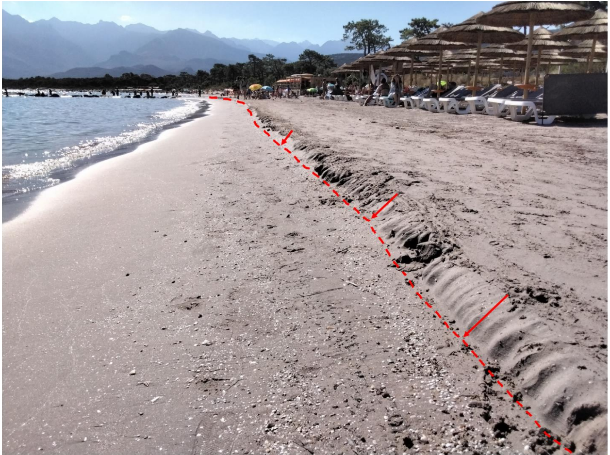
Figure 15 : Microfalaise d'érosion à Calvi (ouest), d'environ 5cm de hauteur, témoignant d'un abaissement du bas de plage et de ruissellement.
