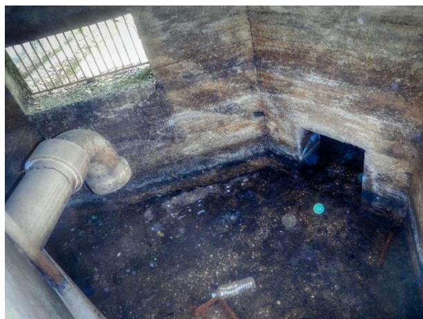
*Figure 61 : Vanne de l'étang de la Retrève : l'alimentation se fait en pied de structure. La vanne est bloquée en position semi-ouverte. Le tuyau avec col de cygne est la prise d'eau qui fonctionne en siphon et envoie l'eau dans le puits absorbant voisin.*
