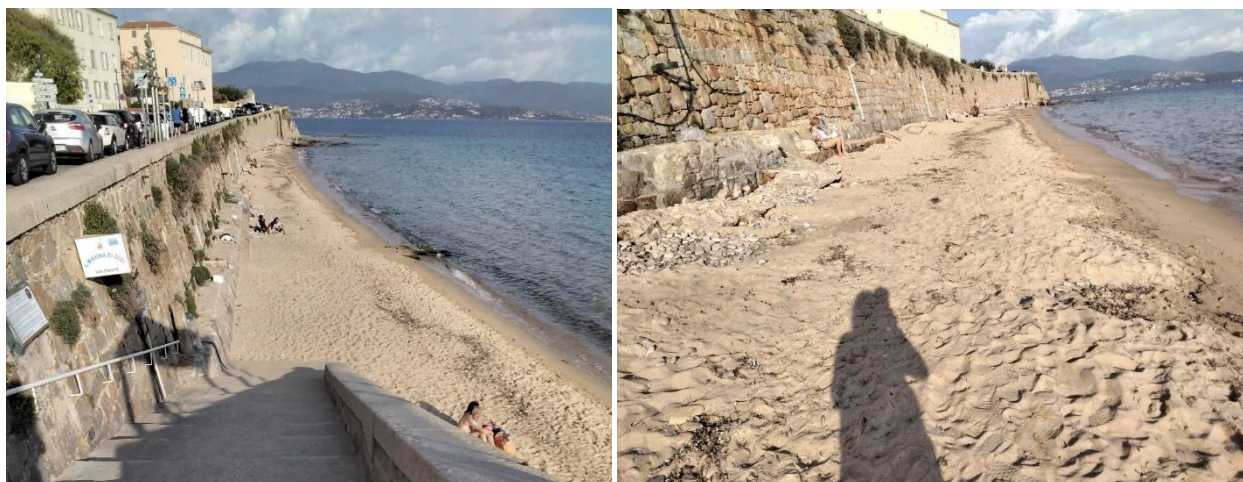
Figure 13 : Plage émergée active bordée par le mur de soutènement à Saint François le 09/05/2022.
