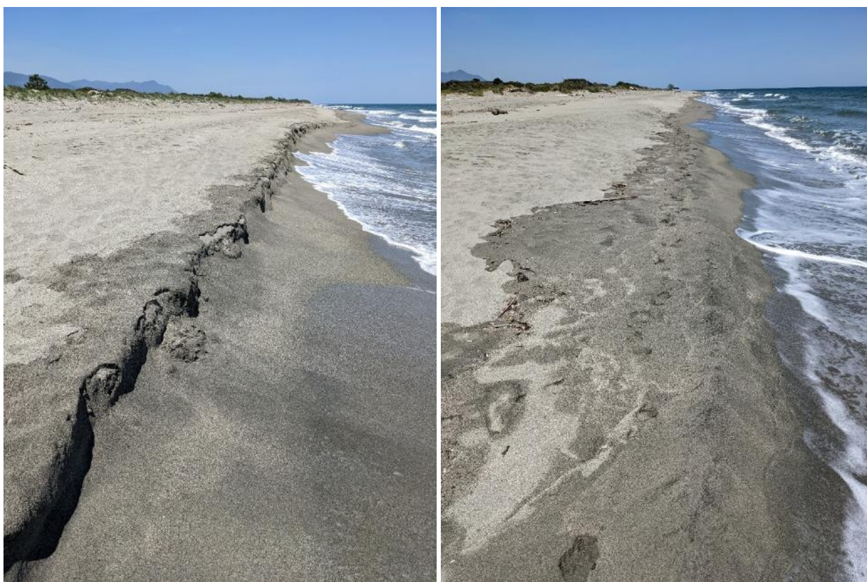
Figure 27 : Site du Tavignano, exemple du trait de côte bas, à gauche une microfalaise d'érosion et à droite une berme (BRGM, 19 mai 2022).
