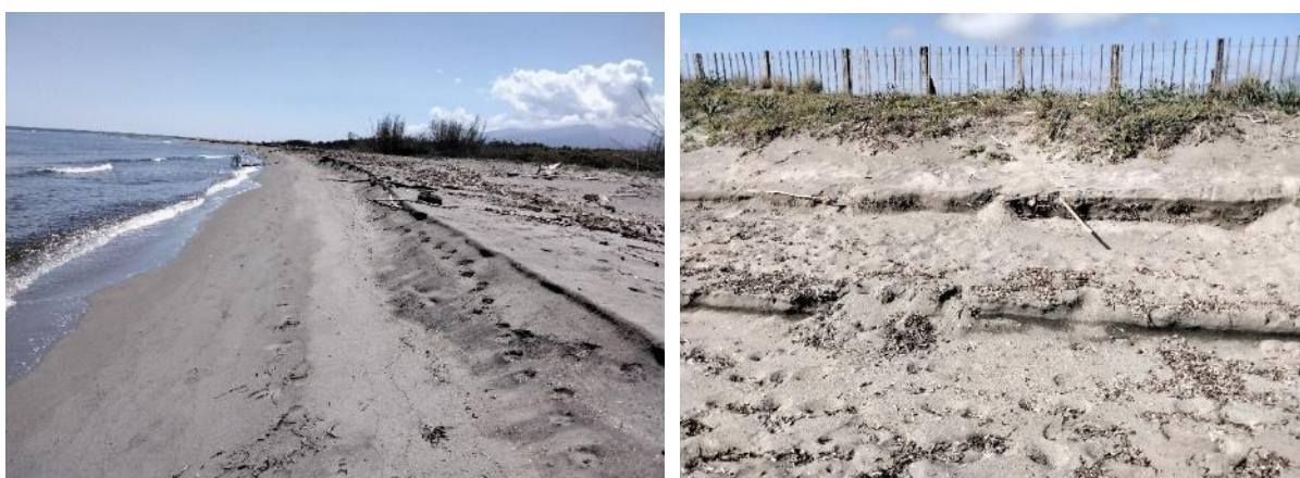
Figure 7 : Site du Lido de la Marana, exemples d'une zone présentant des traces d'érosion au niveau du trait de côte bas (à gauche) et du trait de côte haut (à droite), (BRGM, 26-27 mai 2022).
