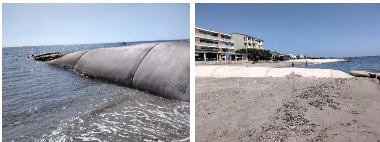
Figure 14 : Site de Campoloro Nord, épis en géotextiles, à gauche au niveau du camping Merendella, à droite au niveau de Moriani-Plage (BRGM, 30 juin 2022).
