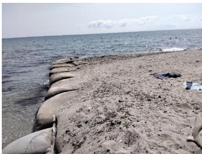
Figure 19 : Epis en sacs géotextile à Campoloro Sud, au niveau de l'hôtel Orizante (BRGM, 01 juillet 2022).
