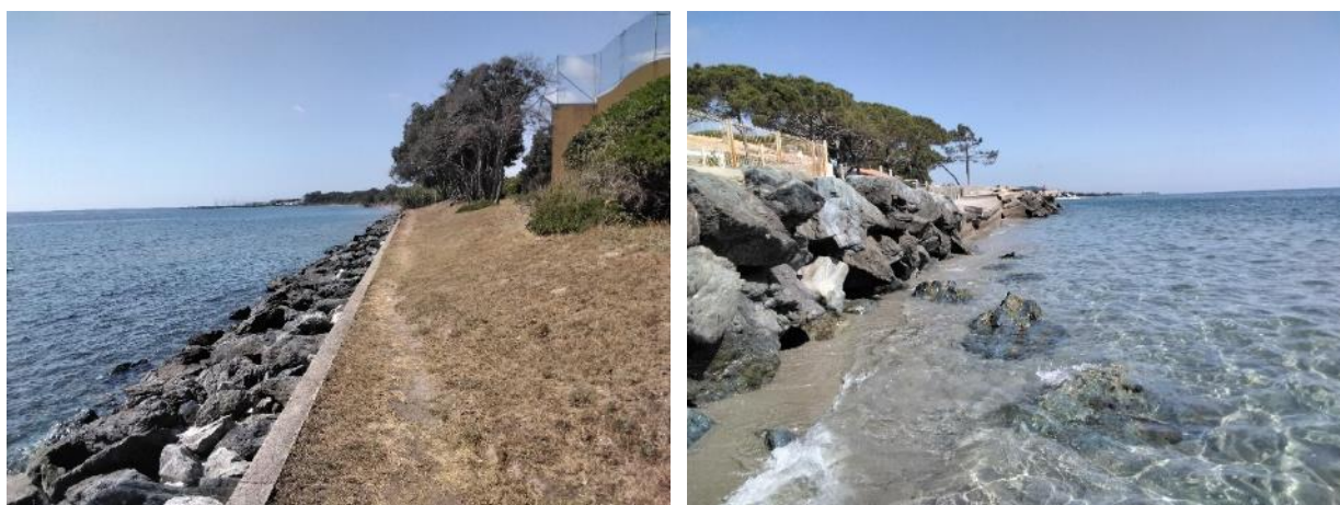
Figure 13 : Site de Campoloro Nord, ouvrages en enrochements, à gauche au niveau de Vanga-Di-L'Oru, à droite au niveau de Moriani-Plage (BRGM, 30 juin 2022).
