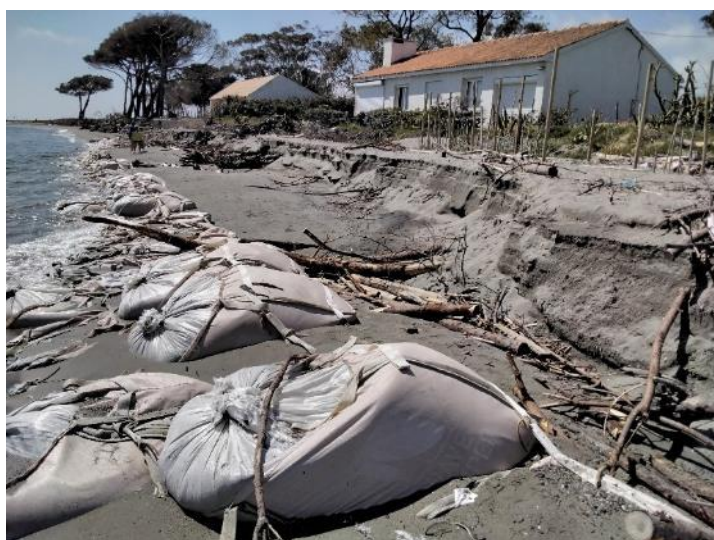
Figure 8 : Site du Lido de la Marana au niveau de Pineto (commune de Lucciana), ouvrage en sacs géotextiles et falaise d'érosion (BRGM, 26-27 mai 2022).
