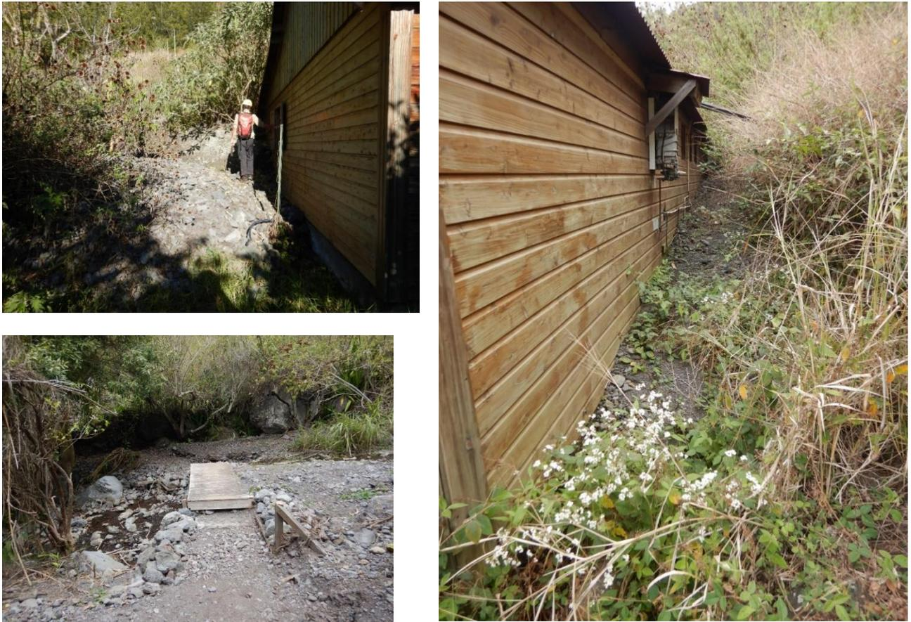
Figure 16 – En haut à gauche et à droite : Gîte Bronchard impacté à son angle sud-ouest (amont) par des matériaux vraisemblablement charriés par une lave torrentielle ; En bas à gauche petit-pont endommagé par les laves torrentielles..
