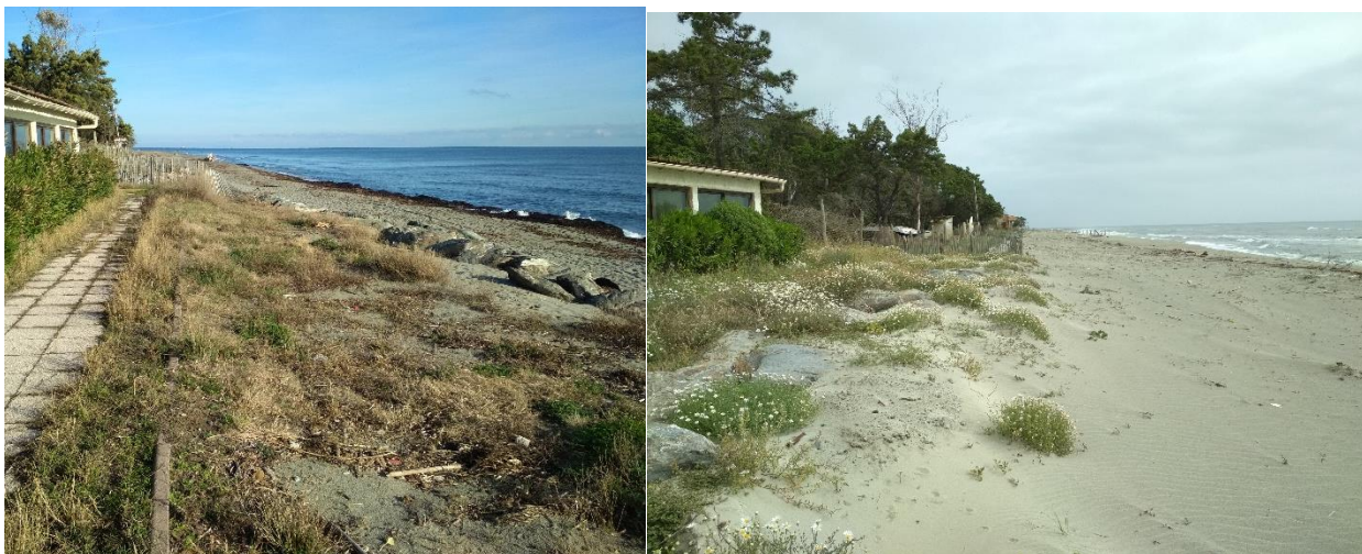
Figure 20 : Apport de sable et élargissement de la plage d'une dizaine de mètres au droit de l'ancien restaurant de Cap-Sud (07/12/2018 à gauche, 14/05/2020 à droite).
