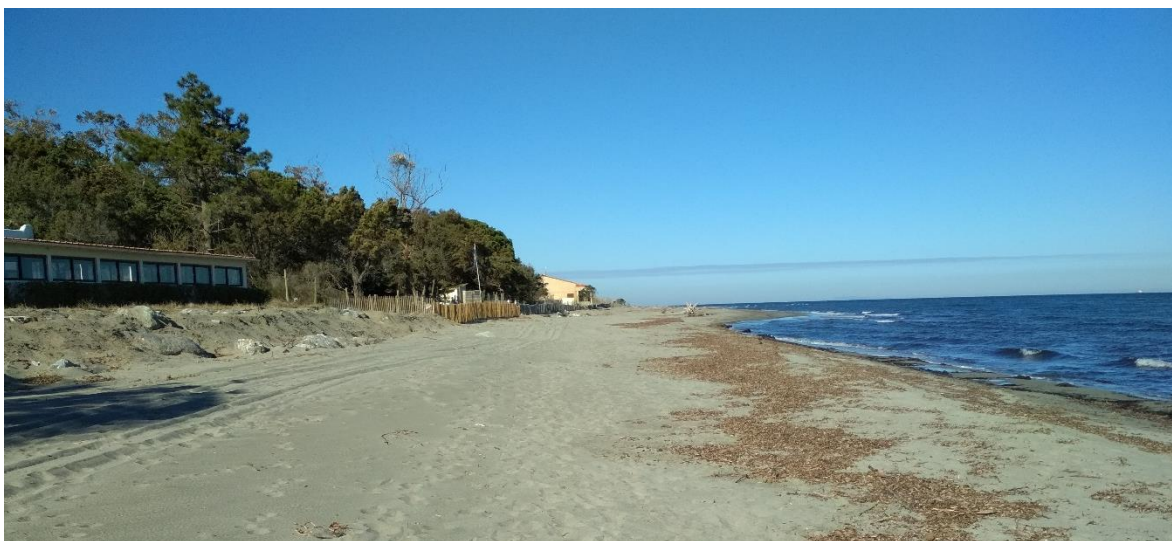
Figure 5 : Enrochement et ancien restaurant du camping de Cap-Sud (14/02/2019).
