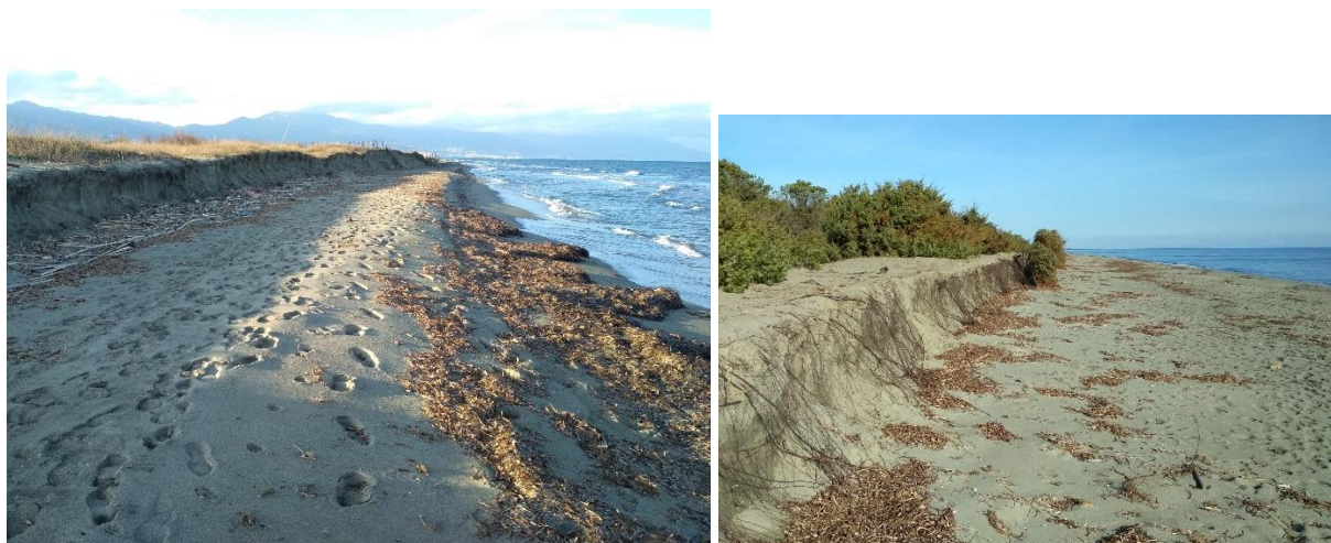
Figure 21 : Site de Maraninca à gauche et site de Mucchiatana à droite (le 07/12/2018, un mois après la tempête Adrian du 29/10/2018).
