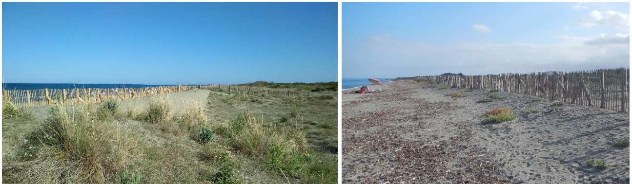
Figure 18 : Exemple de chantier du Conservatoire du Littoral (reprofilage de la dune à gauche, le 02/06/2019, ganivelles à droite le 11/10/2019).
