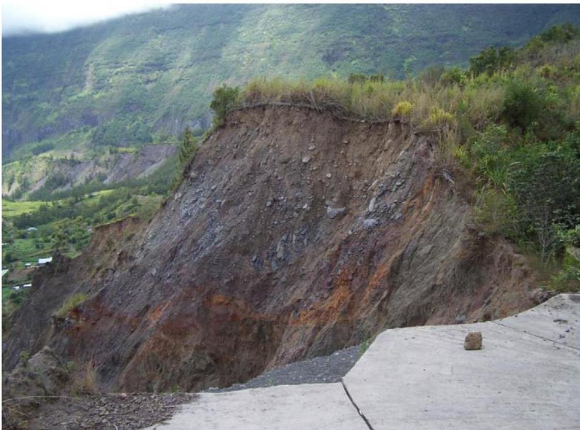
Figure 28 – Erosion régressive en bordure du plateau d'Ilet à Vidot suite à Gamède.
