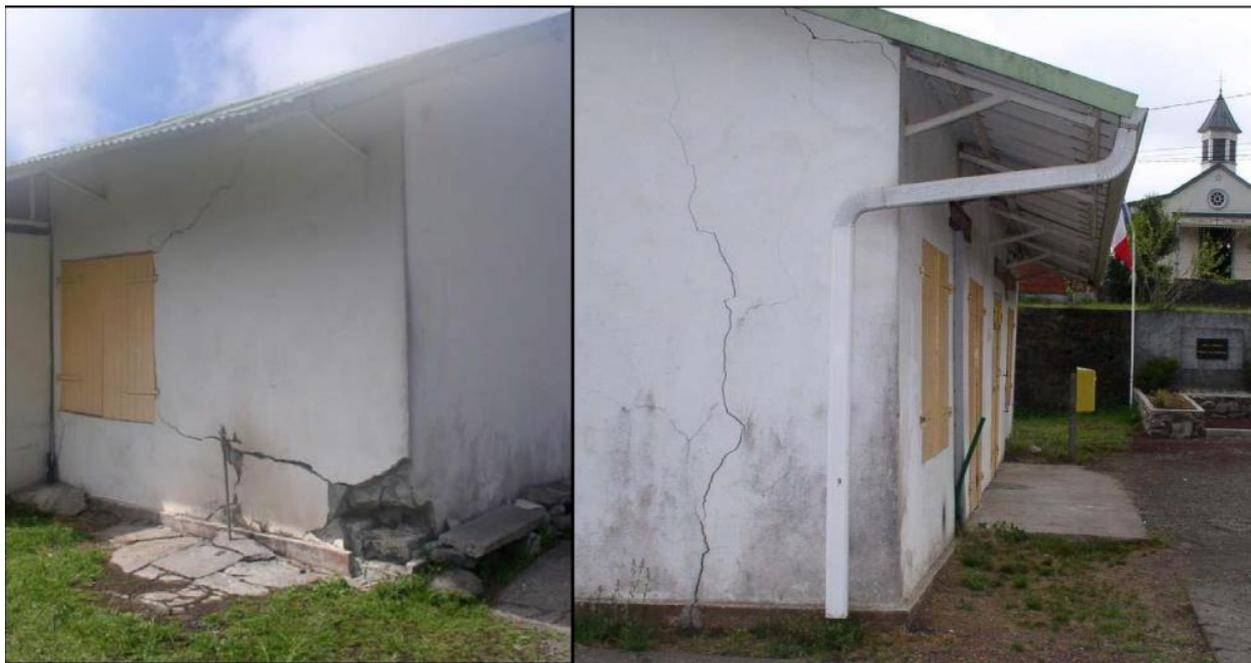
*Figure 38 – Exemples de désordres au bâti observés sur le plateau de Grand Ilet (en haut, école ; en bas, ancienne Poste – Garnier, 2008)*
