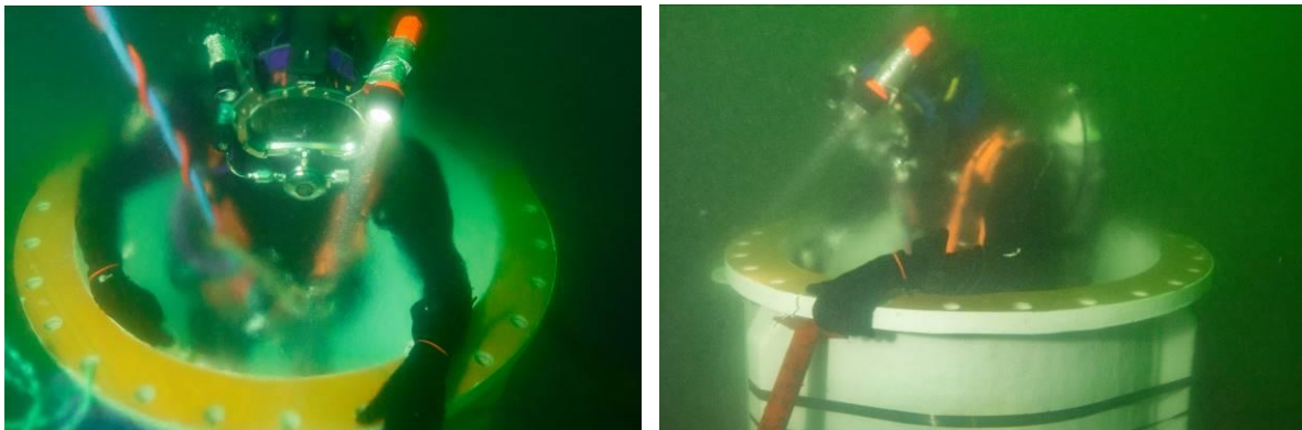
Illustration 7 : Installation du nouveau collecteur.
