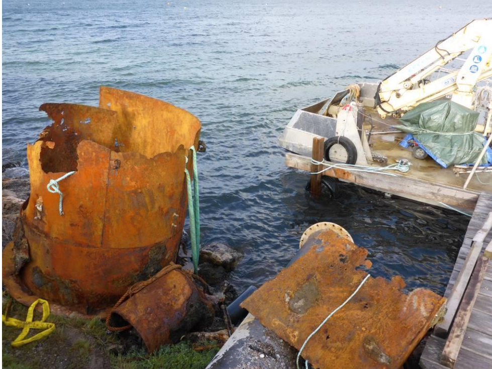
Illustration 5 : Ancienne buse métallique de collecte des eaux de la source de la Vise après sa dépose.
