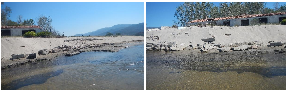
Illustration 9 - Érosion de la dune au niveau de l'embouchure, dégradation (blocs basculés) des bâtiments abandonnés (27 juin 2019).
