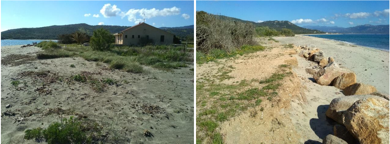
Illustration 13 - Bâtiment du camping situé sur la dune et enrochements dégradés ayant un rôle de protection contre l'érosion marine (30 avril 2019).
