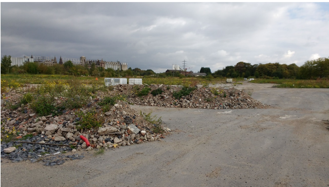
Site B2. Restes de gravats et déchets divers, sols scellés en partie.
