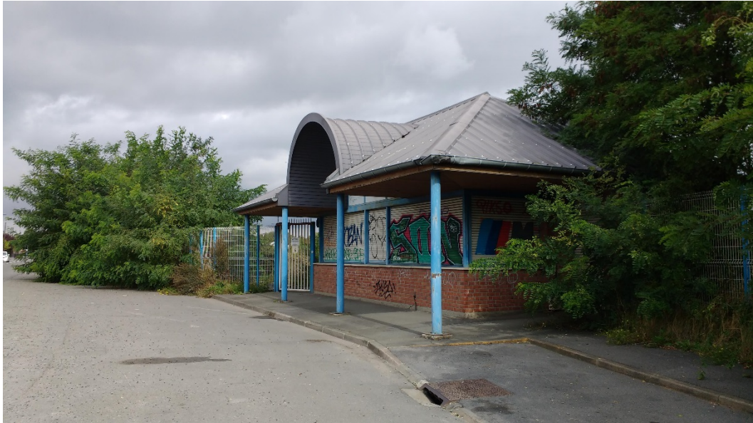
Site de l'ancienne usine du site 2B, bâtiment d'entrée. Présence de faux-acacia tout le long des clôtures du site.
