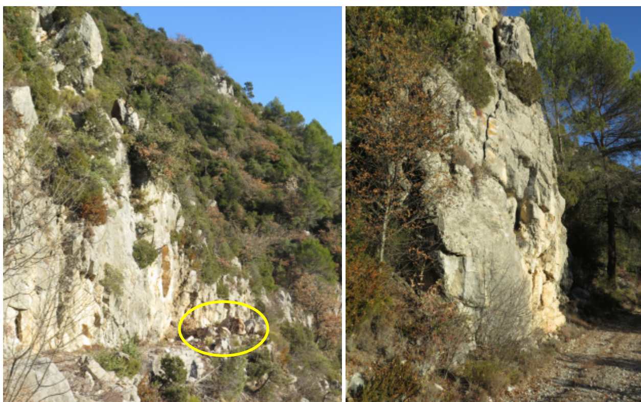
Illustration 19 – Décompression des talus de la piste amont
