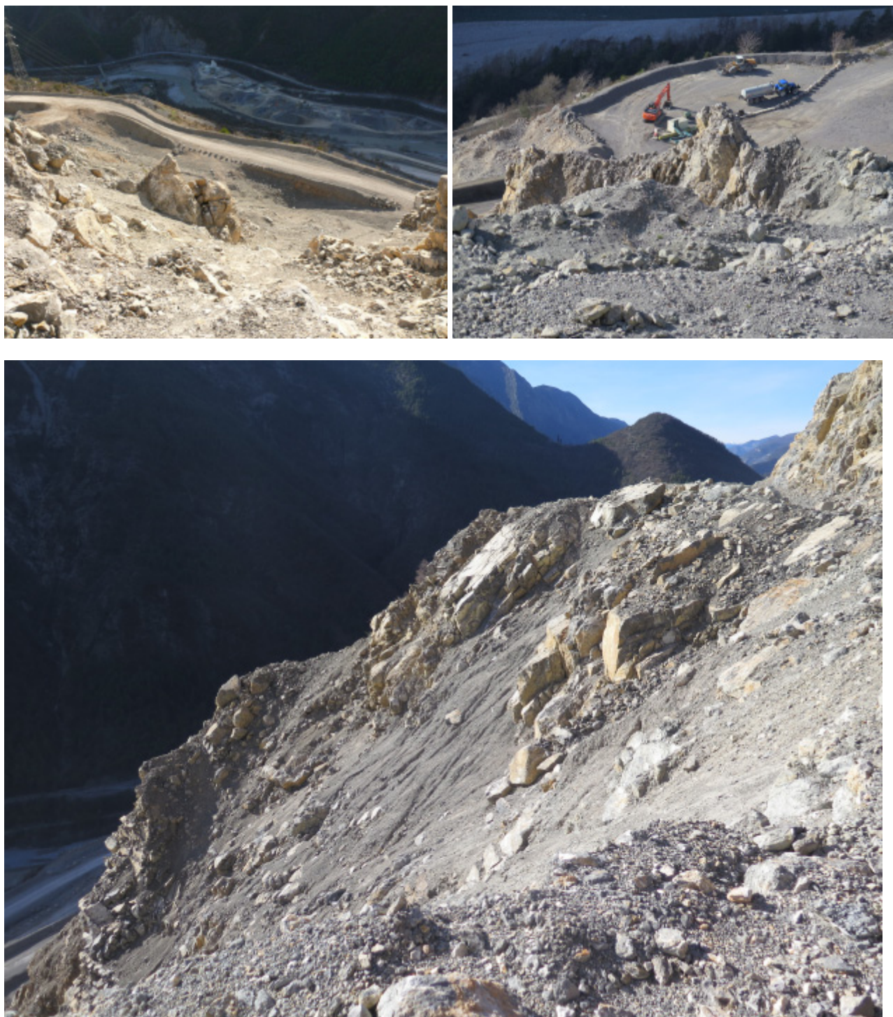
Illustration 24 – Massif décomprimé en aval des fronts définitifs supérieurs
