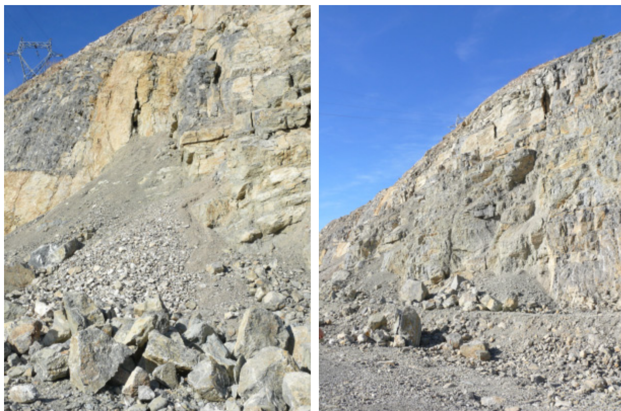
Illustration 21 – Décompression des fronts supérieurs (1)
