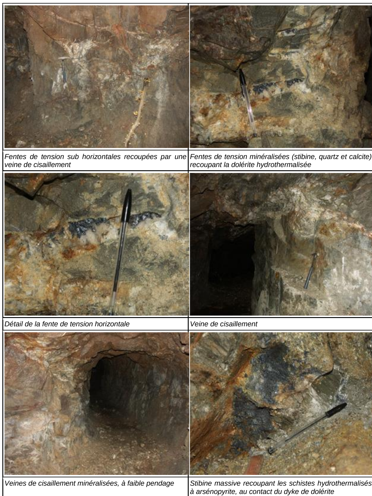
Figure 13 : Photographies dans le niveau -17 m de la mine du Semnon montrant l'état des galeries, la géologie et les minéralisations en 2005, avant la mise en sécurité de la galerie. Clichés E. Gloaguen.
