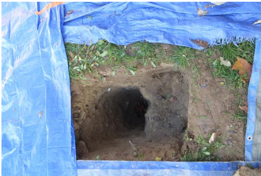
Illustration 7 : Réalisation de l'avant trou
