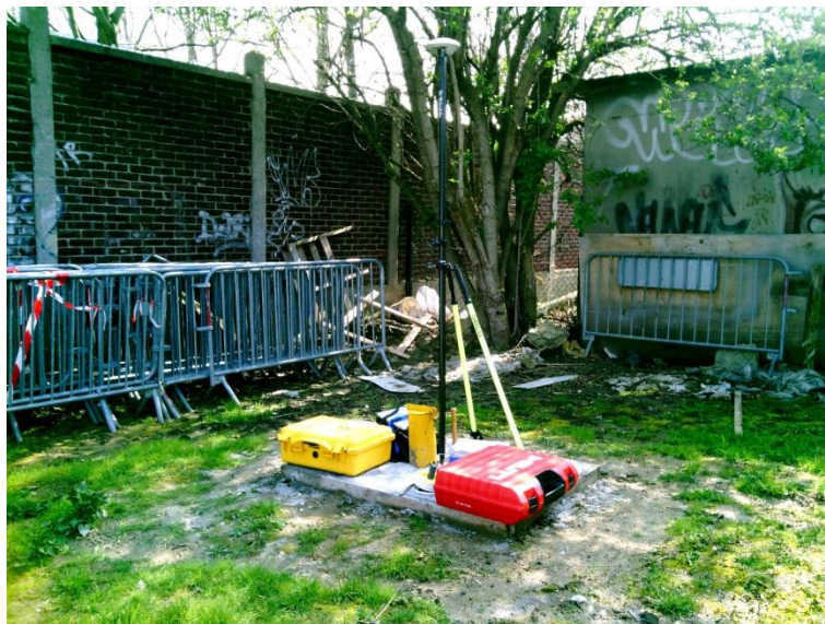
Illustration 6 : Nivellement du piézomètre.
