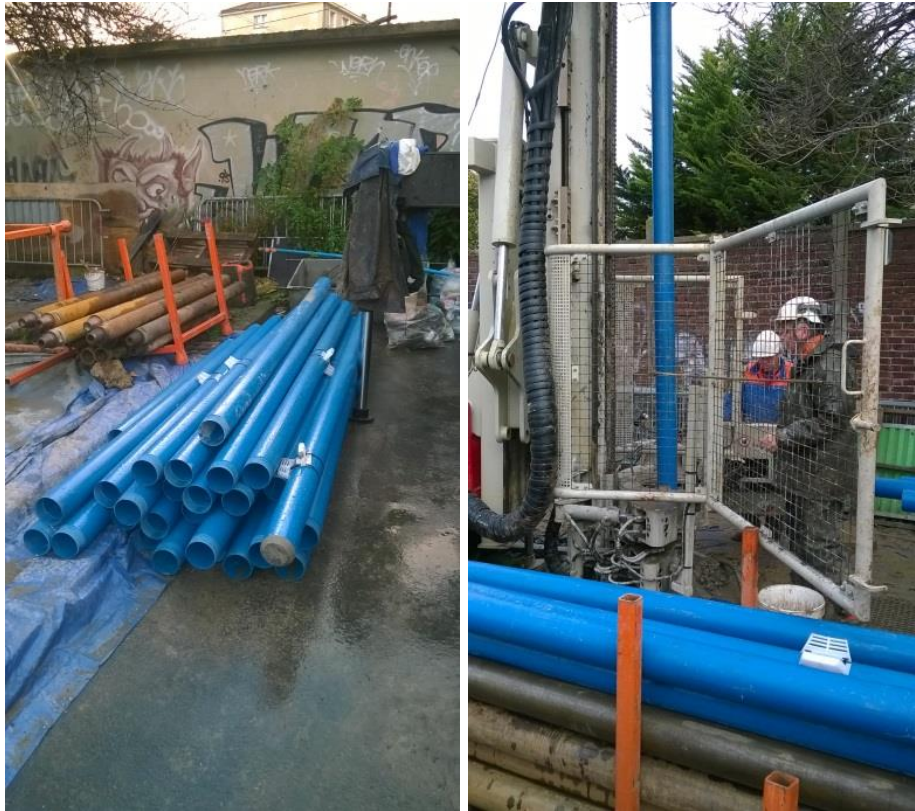
Illustration 13 : A gauche, tubage PVC plein et tubage crépiné avec centreurs et bouchon. A droite, photographie de l'installation du tubage PVC (tube plein)
