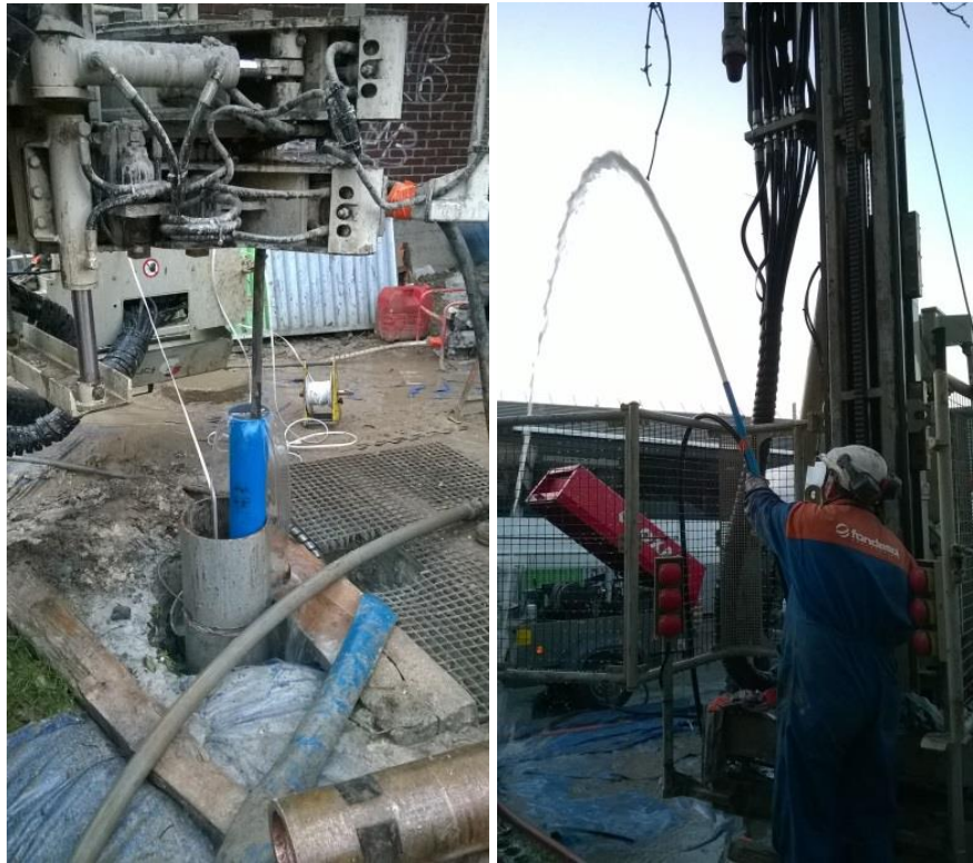
Illustration 15 : Développement de l'ouvrage à l'air lift
