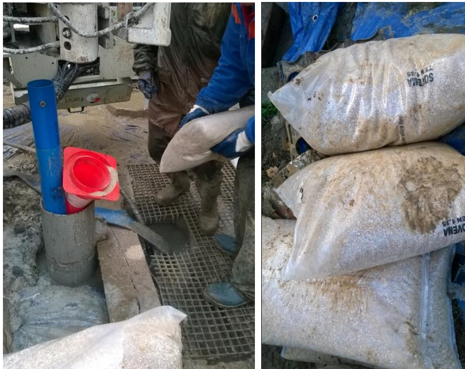
Illustration 14 : Mise en place du gravier filtrant
