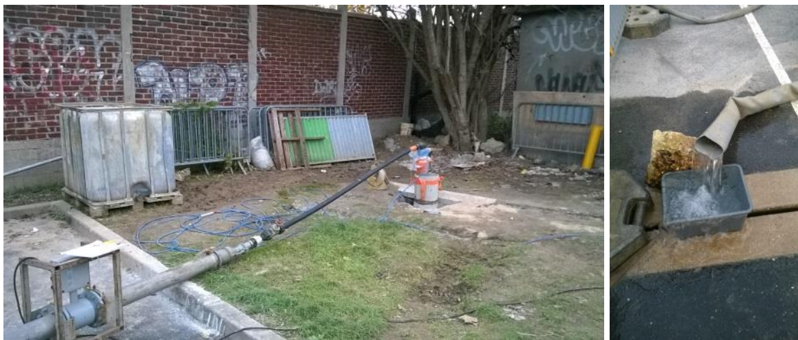
Illustration 18 : Installation de la pompe et début du pompage d'essai
