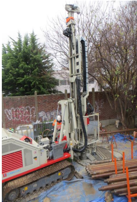
Illustration 12 : Photo du chantier de forage le 19/11/2016
