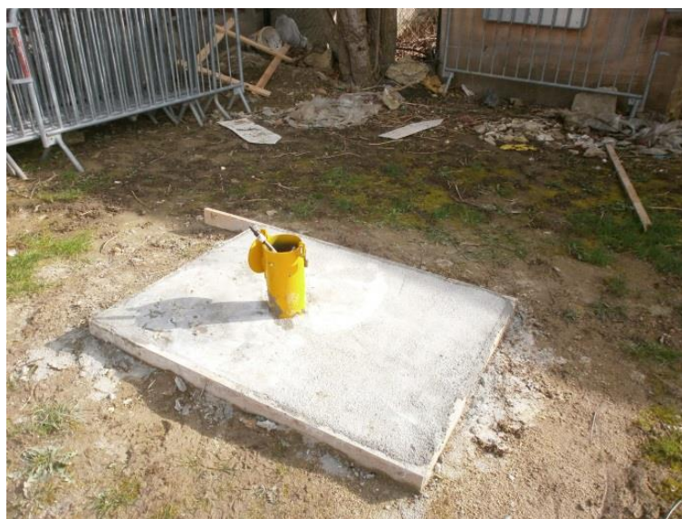
Illustration 4 : Photographie du piézomètre de la Courneuve lors de la réalisation de la margelle
