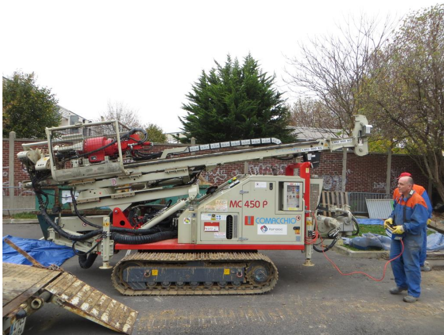
Illustration 8 : Mise en place de la machine de forage MC 450 P Comacchio
