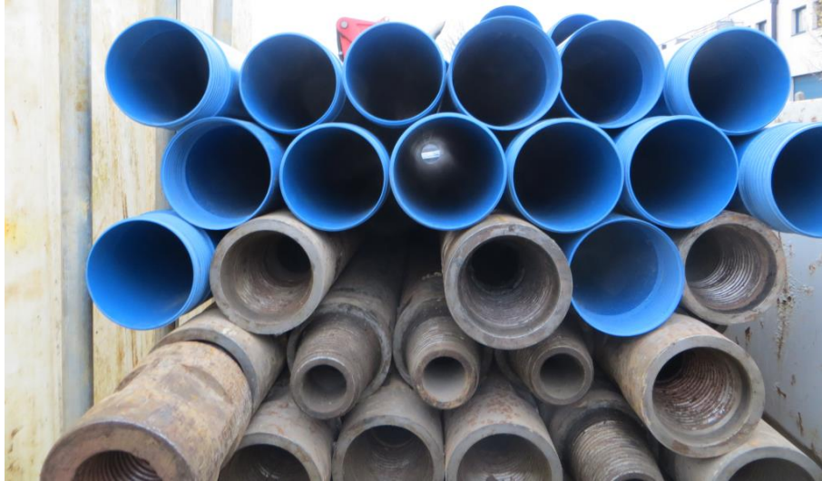
Illustration 10 : Provisionnement des tubages (pleins, crépinés) et des tiges
