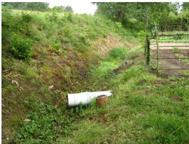
Illustration 11 – exutoire de la conduite de drainage des eaux souterraines dans le ruisseau situé au sud de la parcelle expertisée (photographie BRGM 27/05/15)
