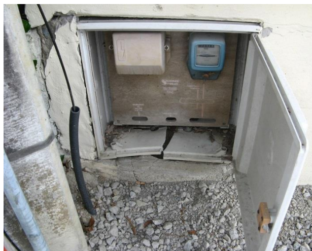
Illustration 10 – décalage du mur de la propriété de M. Pintus (flèche rouge), coffret électrique éclaté (photographies BRGM 27/05/15)
