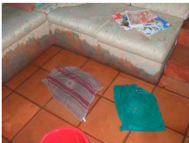
Illustration 8 – photographies prises durant les inondations : à gauche dégâts touchant la banquette, à droite traces de remontée d'eau à travers les joints du carrelage avec dépôts blanchâtres correspondant au lessivage du laitier de ciment (photographies propriétaire)
