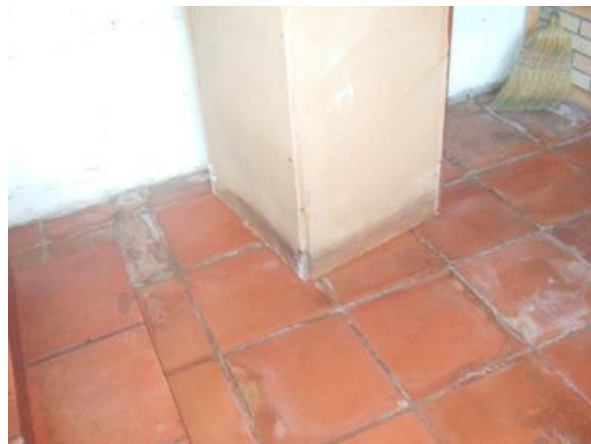
Illustration 8 – photographies prises durant les inondations : à gauche dégâts touchant la banquette, à droite traces de remontée d'eau à travers les joints du carrelage avec dépôts blanchâtres correspondant au lessivage du laitier de ciment (photographies propriétaire)
