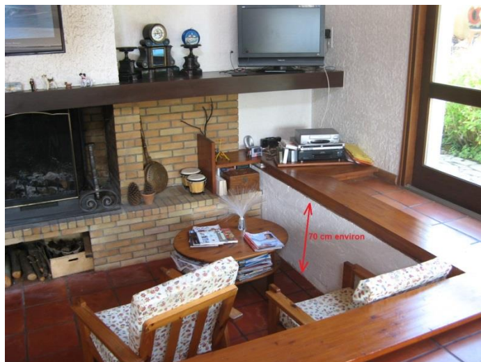
Illustration 9 – photographie de la partie du salon qui a été inondée en janvier/février 2014 (photographie BRGM, 27/05/14)
