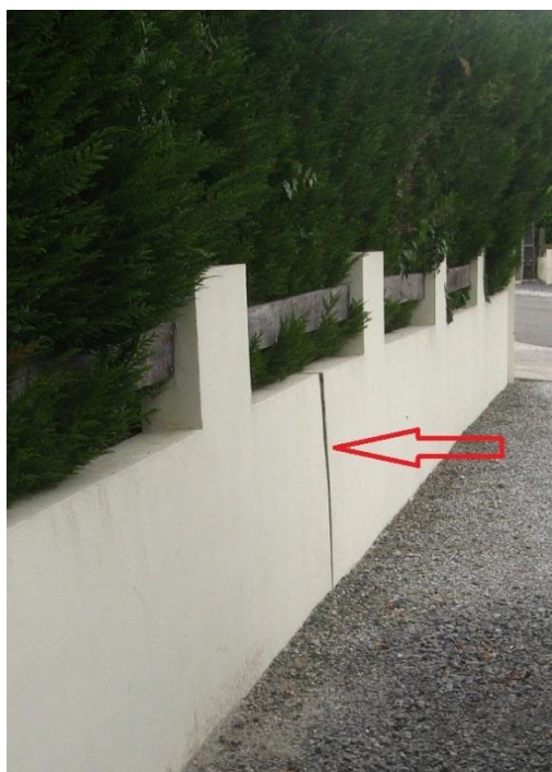
Illustration 10 – décalage du mur de la propriété de M. Pintus (flèche rouge), coffret électrique éclaté (photographies BRGM 27/05/15)
