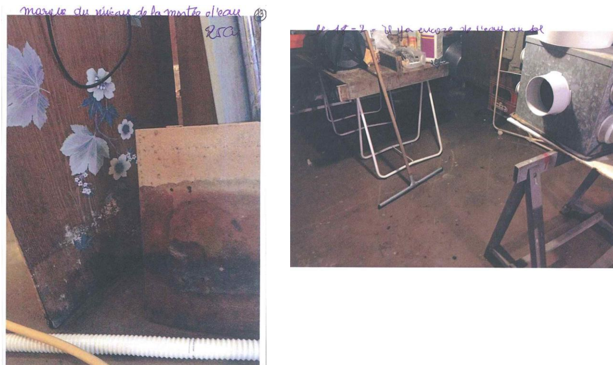
Illustration 8 – photographies prises durant les inondations : à gauche traces de la remontée d'eau (environ 25 cm/dalle), à droite persistance de l'eau le 18/02/14 (photographies propriétaire)
