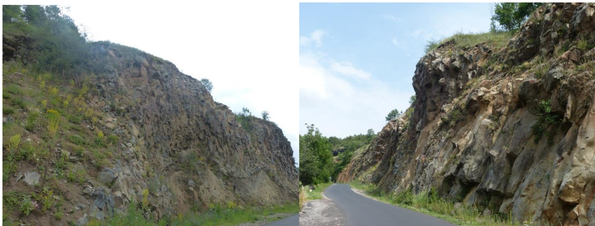
Illustration 30 : Partie centrale - coté sud (vues opposés)
