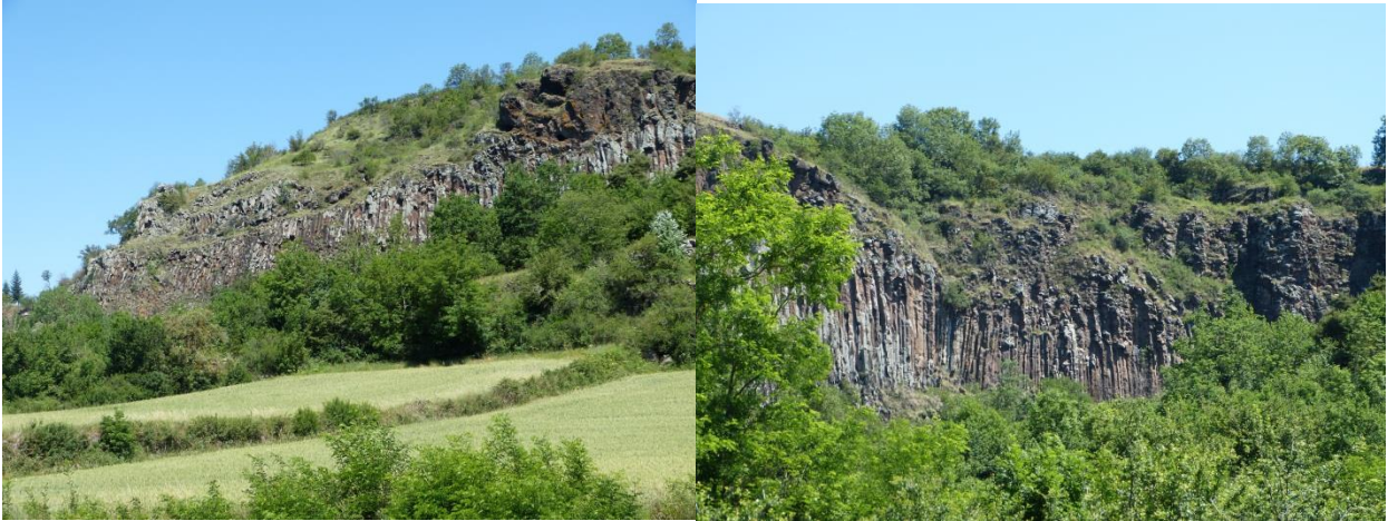
Illustration 34 : aperçu de la tête de falaise du prolongement sud et du versant en amont
