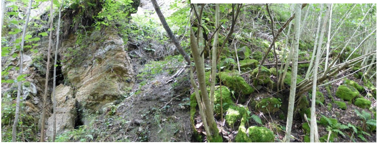
Illustration 65 : instabilités ponctuelles dans le versant au dessus de la Borne (mélangeant généralement matériaux rocheux et meubles)
