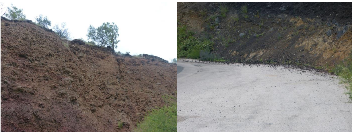
Illustration 24 : Aspect de la paroi du front de taille et des éboulis cendreux
