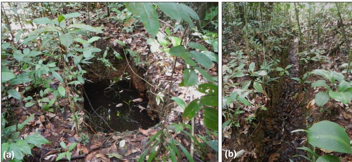
Fig. 6 – Travaux de prospection du BMG observés lors de la mission d'échantillonnage. Puits de prospection (a) et tranchée (b) réalisés pour le cubage des alluvions-éluvions de l'indice Balata-Jupiter.
