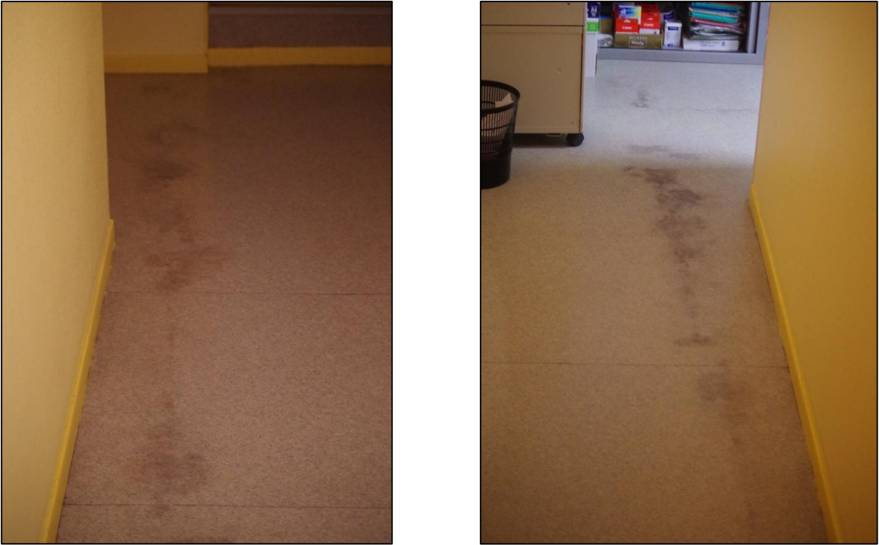
Figure 7 : Traces d'humidité observées au niveau du bâtiment occupant la parcelle AE89 (cliché BRGM 05/11/13)
