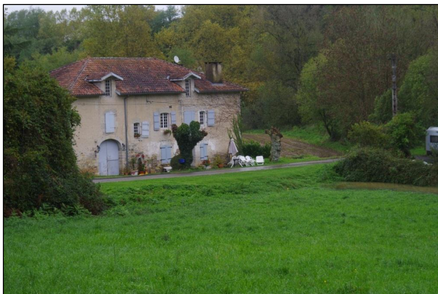
Figure 10 : Vue de la bâtisse impactée située vers Pédeberdoly ; à noter que la Bidouze passe en arrière-plan, au niveau des grands arbres (cliché BRGM 05/11/13)
