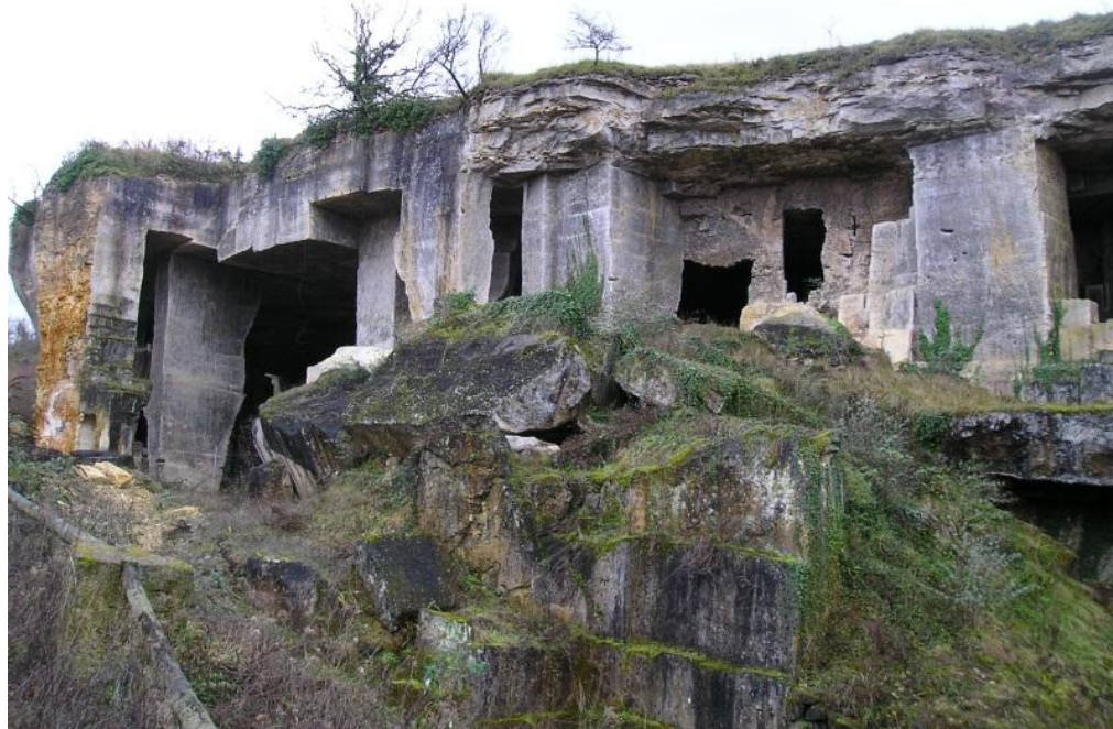
Illustration 13 – Photo d’une entrée de carrière effondrée dans la commune de St-Même-les-Carières
