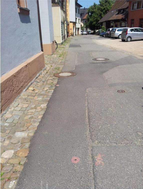
*Photo 19 – Repère au sol de nivellement pour le suivi topographique de la zone impactée*
