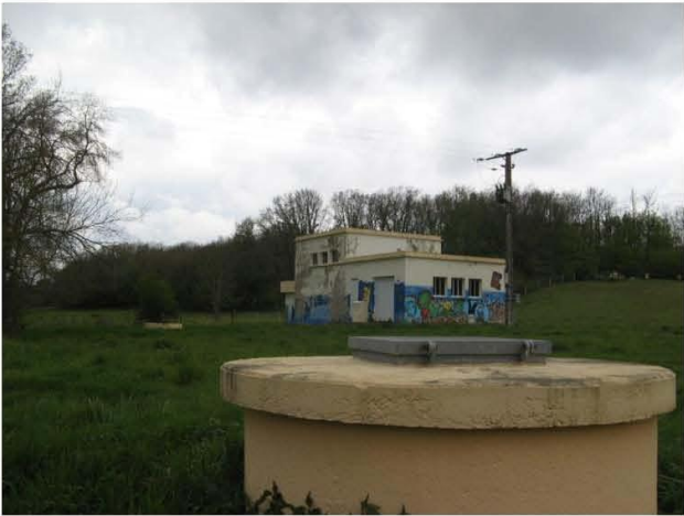
Illustration 121.4 : Photographie du champ captant de Fontaine Rateau à Coussay-les-Bois (86), un des rares forages AEP au Turonien encore en exploitation
