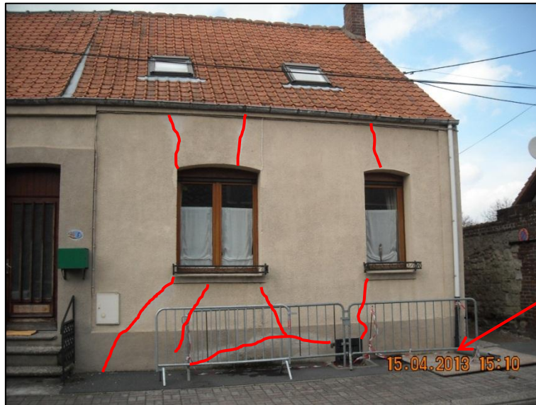
Figure 7 : Repérage des fissures sur la façade côté rue d'Haspres
