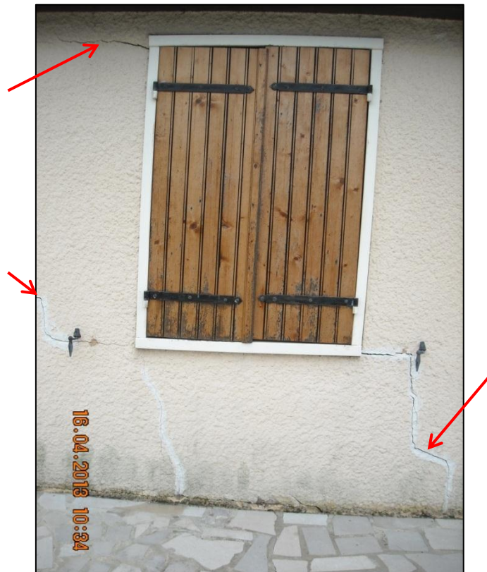
Figure 10 : Zoom sur la fenêtre nord (façade nord-ouest)
