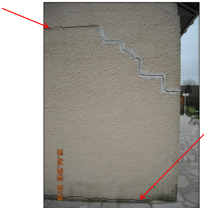
Figure 6 : Détail de l'angle nord de la façade nord-est
