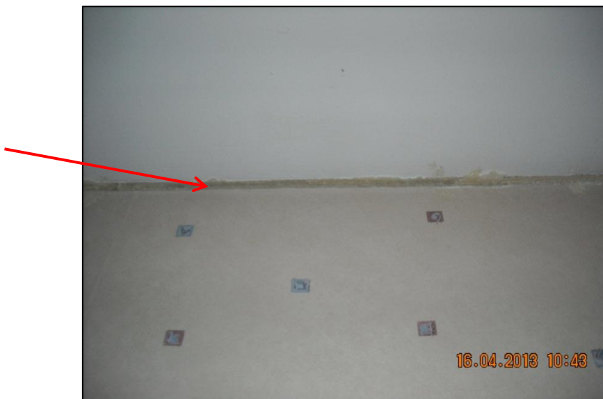
Figure 14 : Fissure horizontale au plafond
