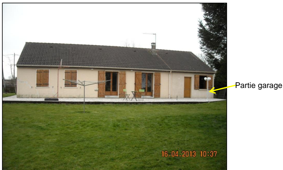
Figure 7 : Vue générale de la façade nord-ouest
