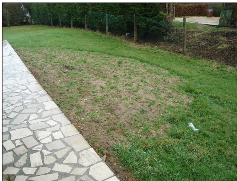
Figure 3 : Cliché pris par les propriétaires à la fin des travaux de comblement en février 2012
