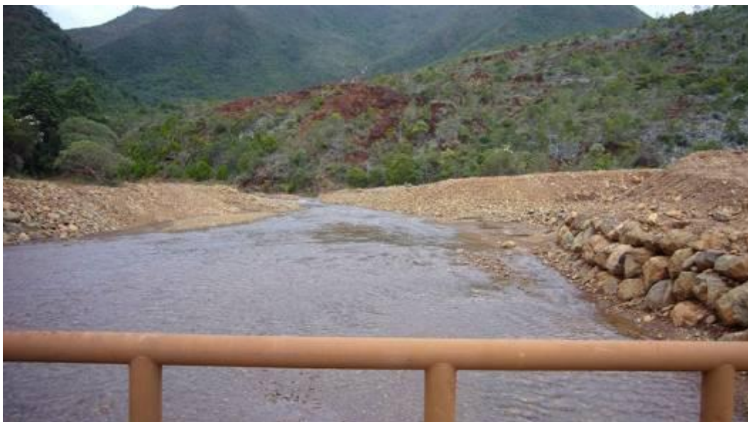
Illustration 65 : Modification, rectification et aménagement dans le lit de la Waneubwayo.
