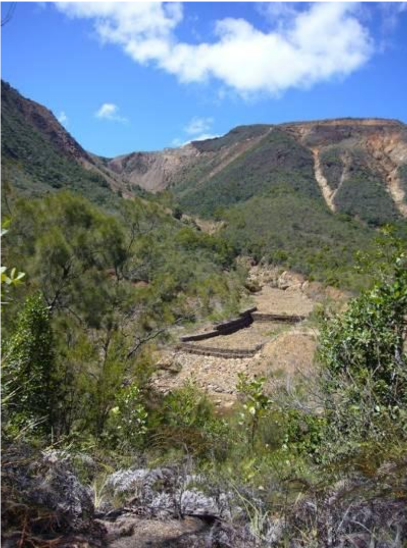
Illustration 41 : Dispositif de piégeage de la charge solide dans un creek en aval de la concession Surprise 2 Red, bras Est de la Népoui.
