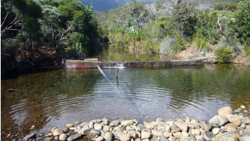
Illustration 64 : Barrage et captage sur la Troulala (Pt105).
