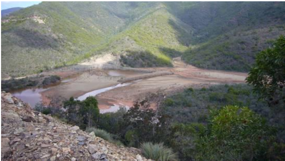
Illustration 40 : Bassin de piégeage de sédiments dans la branche Est de la Népoui (Pt131).
