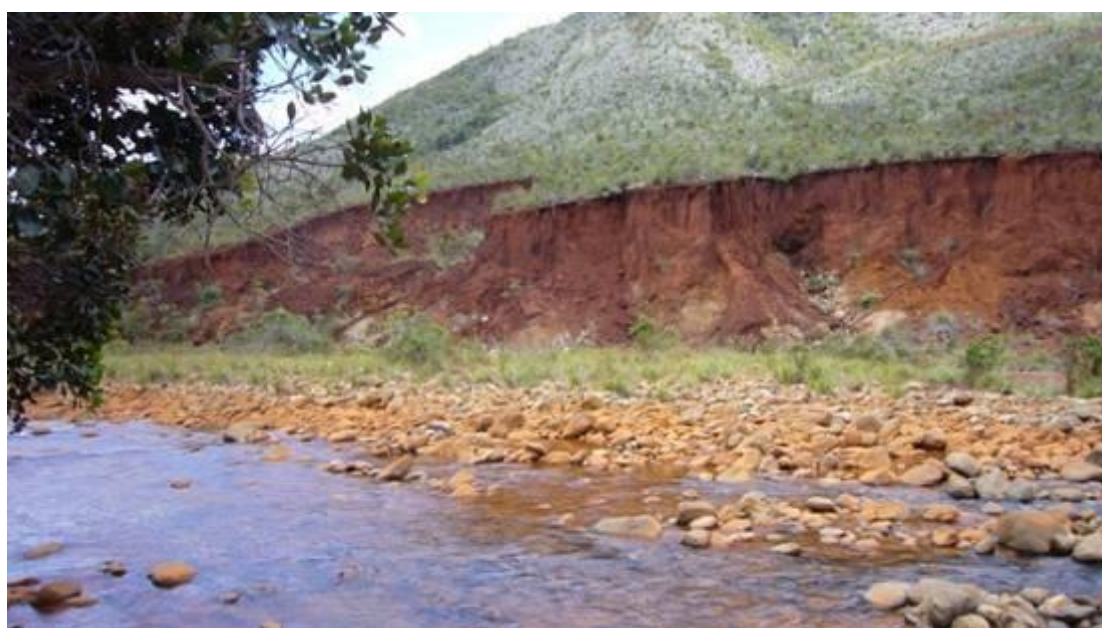
Illustration 52 : Érosion d'une berge latéritique par la Coulée (Pt45).
