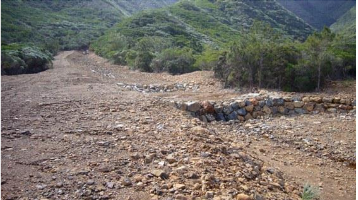
Illustration 17 : Rectification, curage et aménagements de la Bwa Néca.
