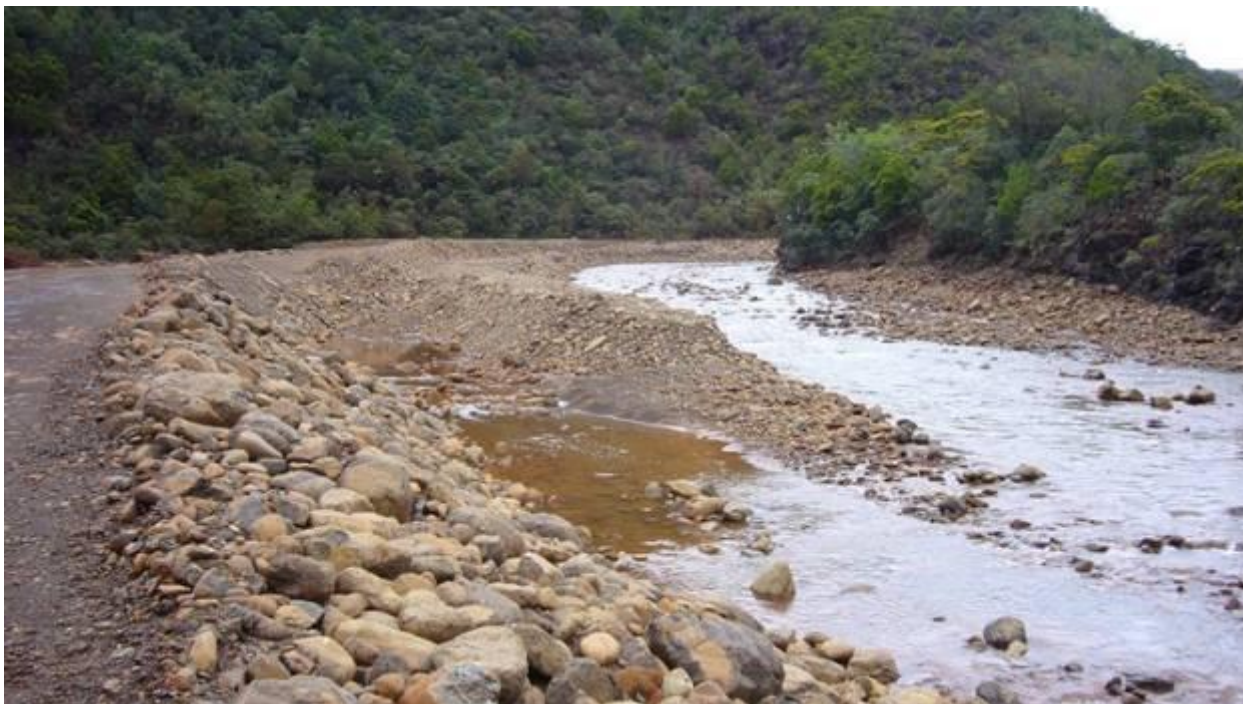
Illustration 25 : Curage, rectification et aménagement de piste dans le lit sur-engravé de la Wayo Wia (Pt171).
