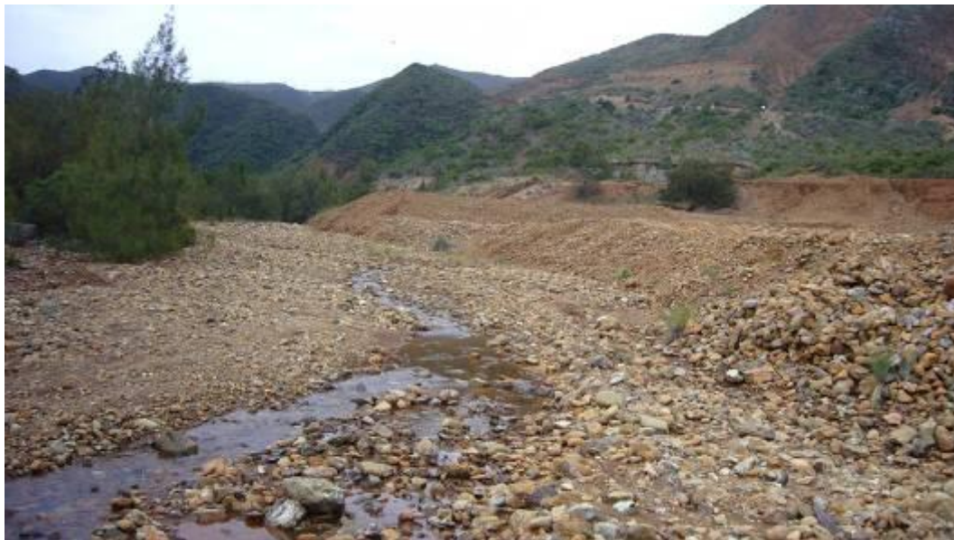
Illustration 74 : Curage de lit et rectification de tracé dans une zone sur-engravée de la Poro (Pt185).
