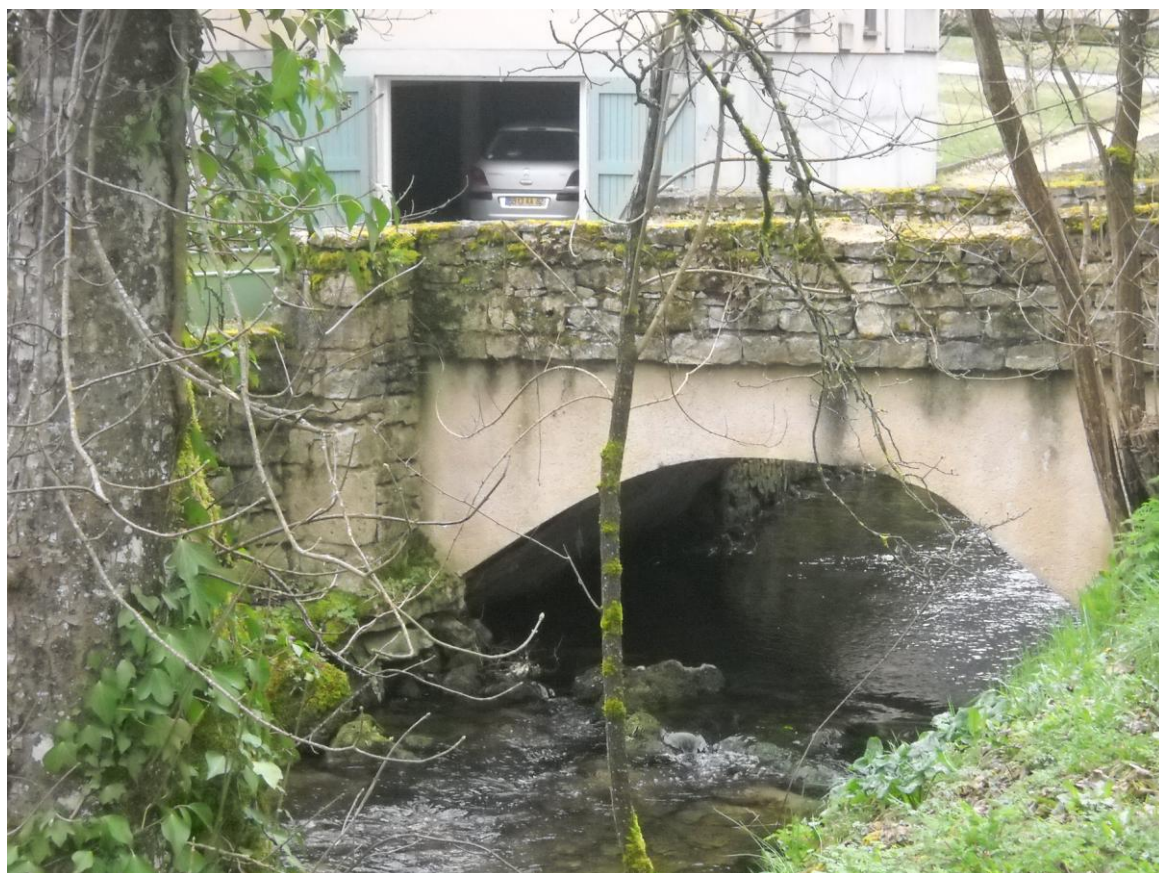
Vue de près de l'aval immédiat du second pont du Livron
