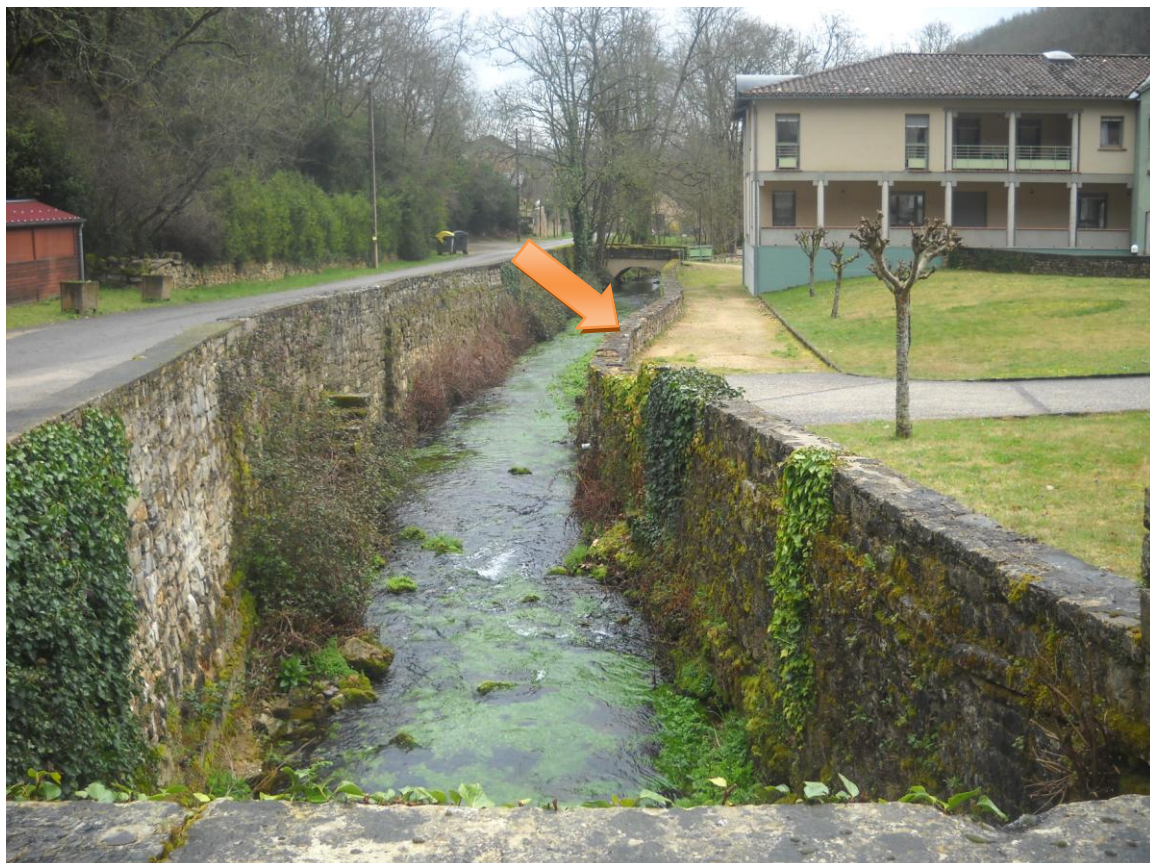
Vue du second pont depuis le 1 er pont du Livron
