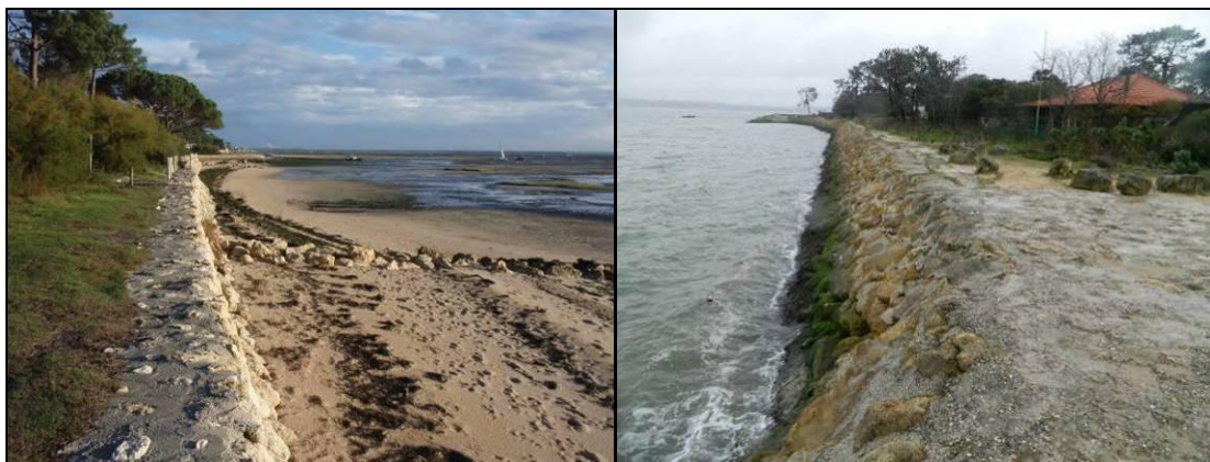
Figure 10 : Exemple d'ouvrage de fixation du trait de côte (commune d'Arès à gauche, commune de Lège-Cap-Ferret à droite).
