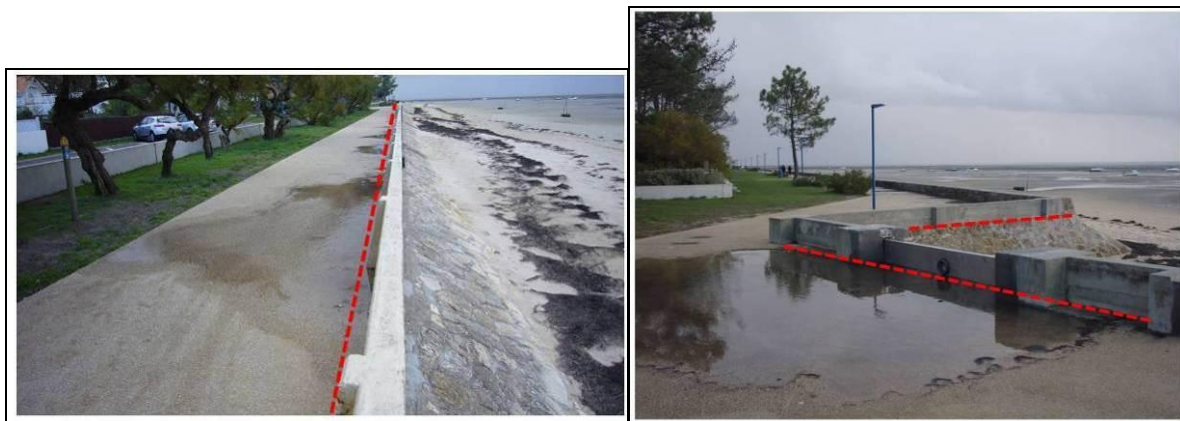
Figure 11 : Ouvrage de fixation du trait de côte (perré) rehaussé d'un muret (commune d'Andernos-les-Bains en exemple). Ligne en pointillés rouge : niveau du terrain naturel.
