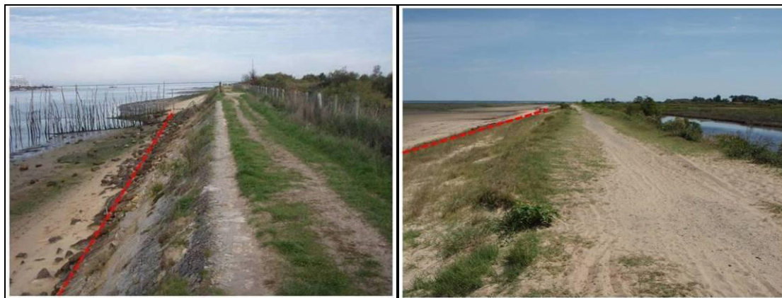
Figure 12 : Ouvrages de protection contre la submersion marine de type digue (commune de La Teste-de-Buch en exemple). Ligne en pointillés rouge : niveau du terrain naturel.
