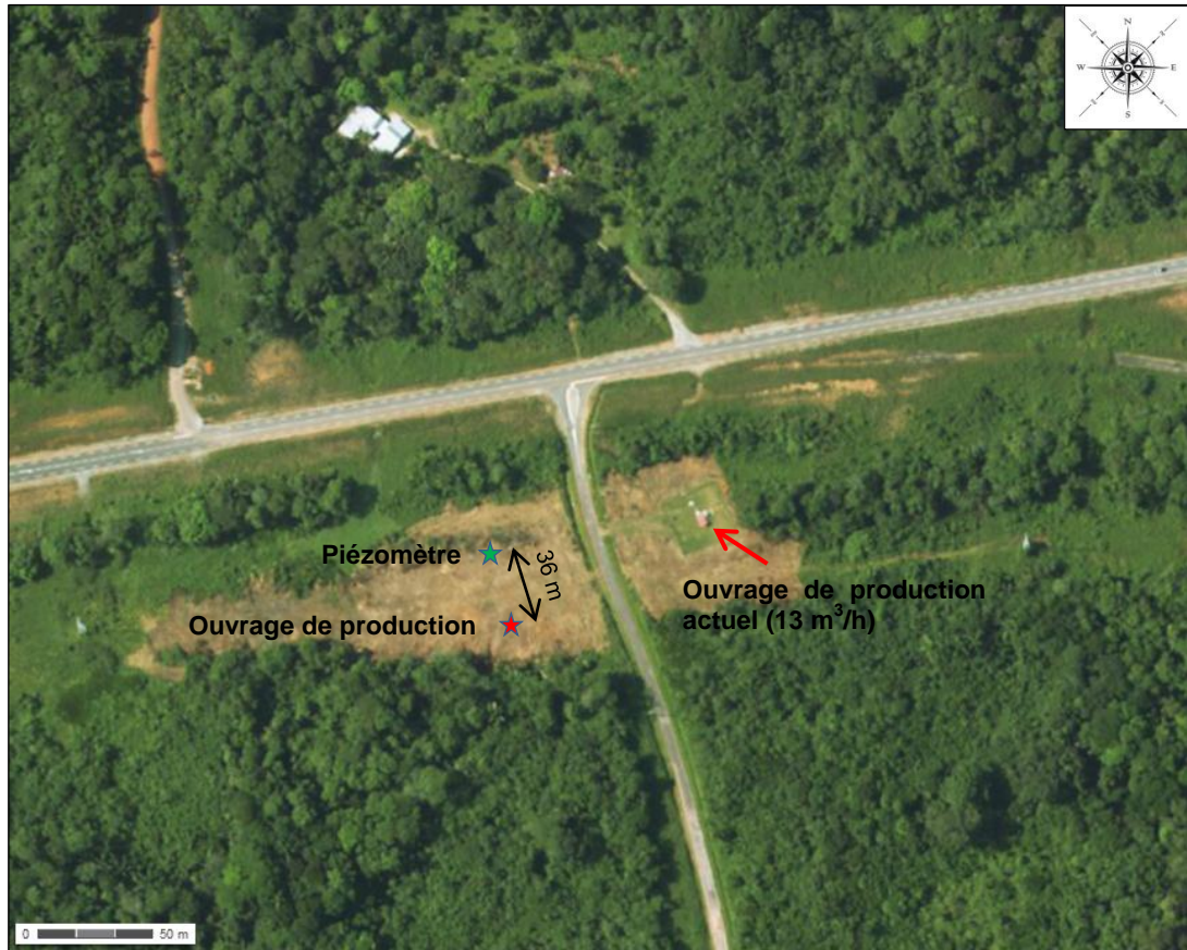
Illustration 5 : Localisation des ouvrages réalisés
