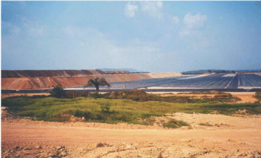
*Figure 8 : exemple de lixiviation en tas au Ghana*
