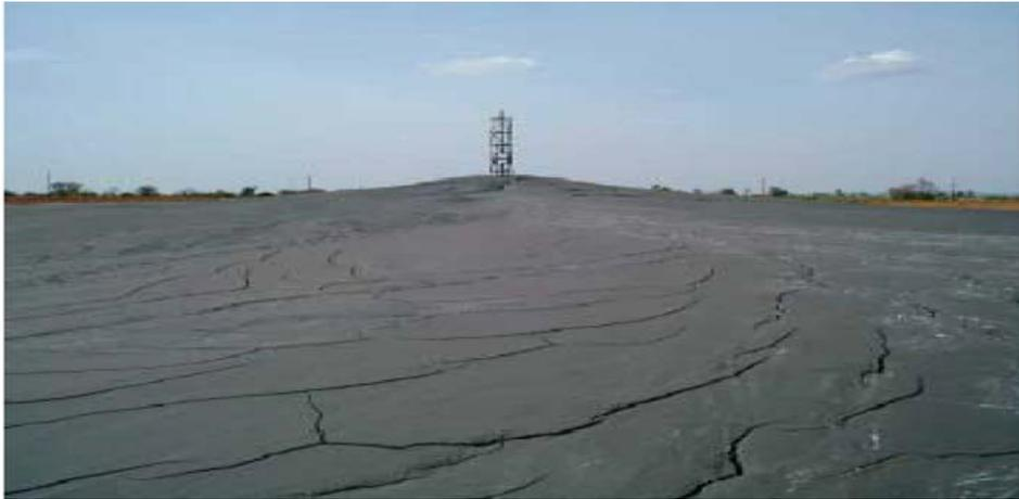
*Figure 16 : Exemple de stockage de résidus épaissis*
