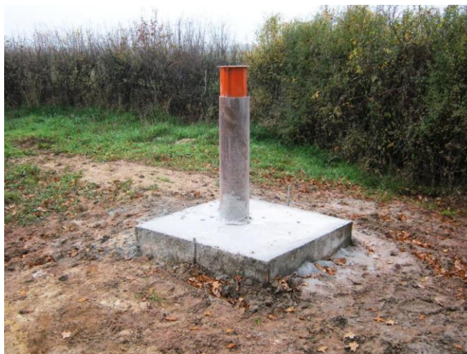
Figure 8 : photo de la tête du piézomètre et de la dalle de propreté
