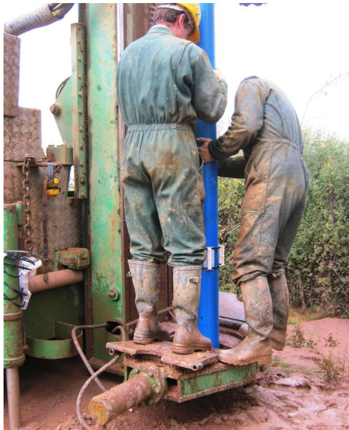
Figure 4 : Mise en place du tubage PVC (avec centreur)
