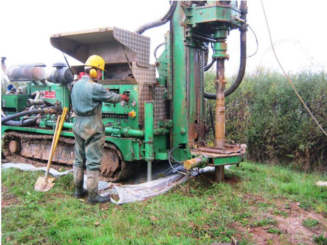
Figure 3 : photo de la foreuse, en début de chantier
