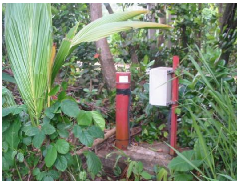
Illustration 7 : Forage Marigot – Anse Charpentier (février 2011)
