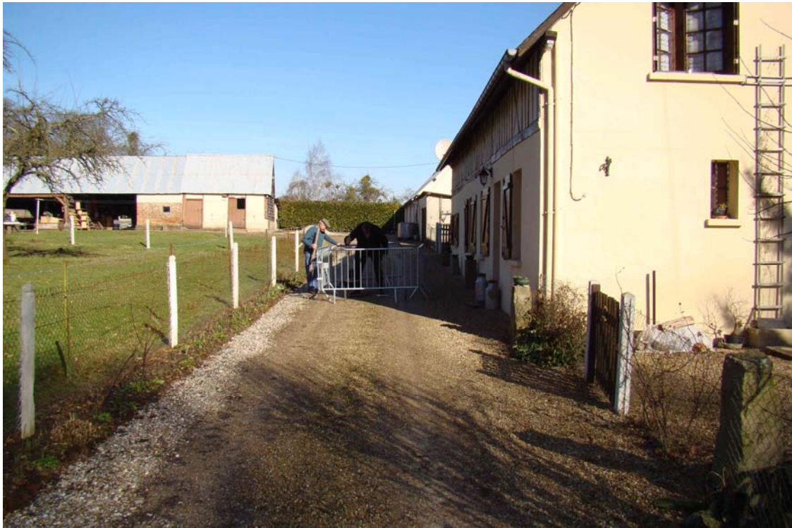
Photo 1 : Vue de l'effondrement et de la maison à proximité.
