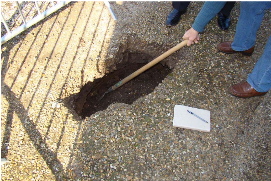
Photo 2 : Vue de l'excavation.
