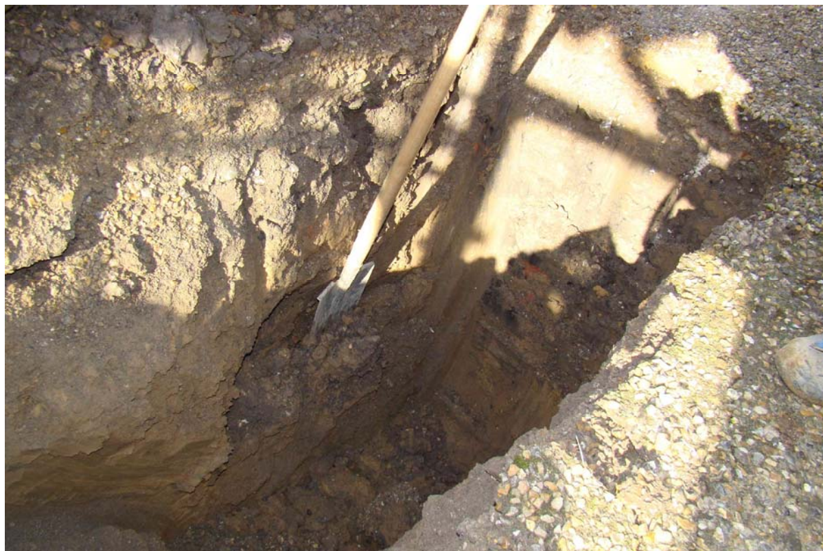
Photo 3 : Vue de la zone décompressée après ouverture de l'excavation par la mini-pelle.
