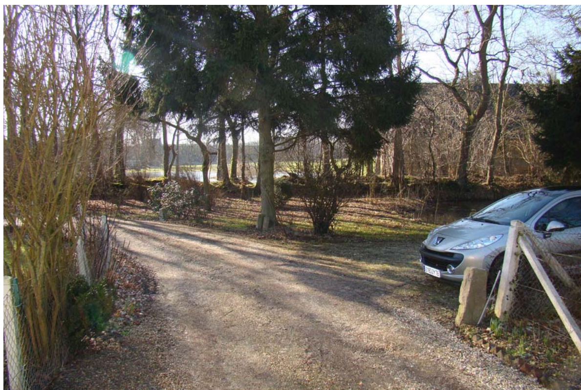
Photo 4 : Vue du chemin à l'aval de l'excavation ; mare visible derrière la voiture.
