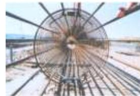
*Armatures d'un pieu géothermique*
