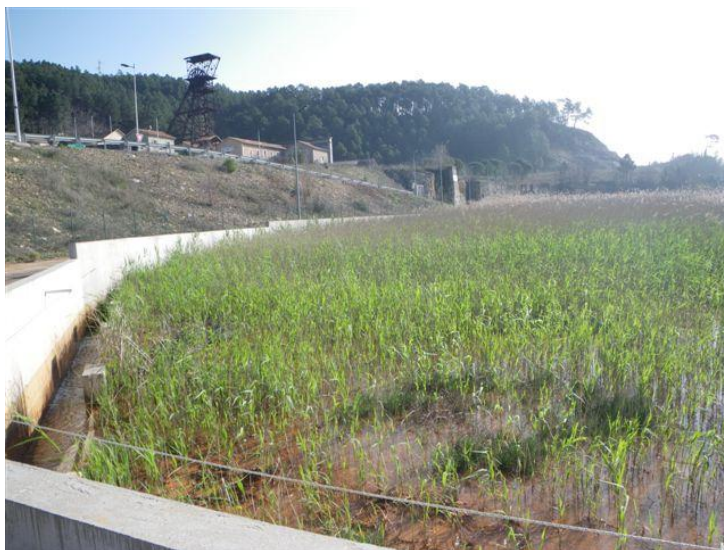
Illustration 6 - Lagune de la station Destival – Commune de Saint-Martin-de-Valgagues.
