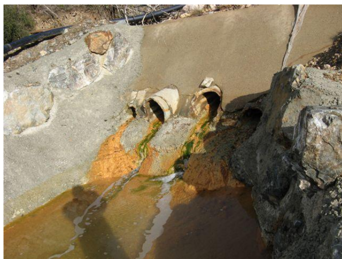
Illustration 26 - Sorties drains et penstocks Artus – Commune de Limousis (11).
