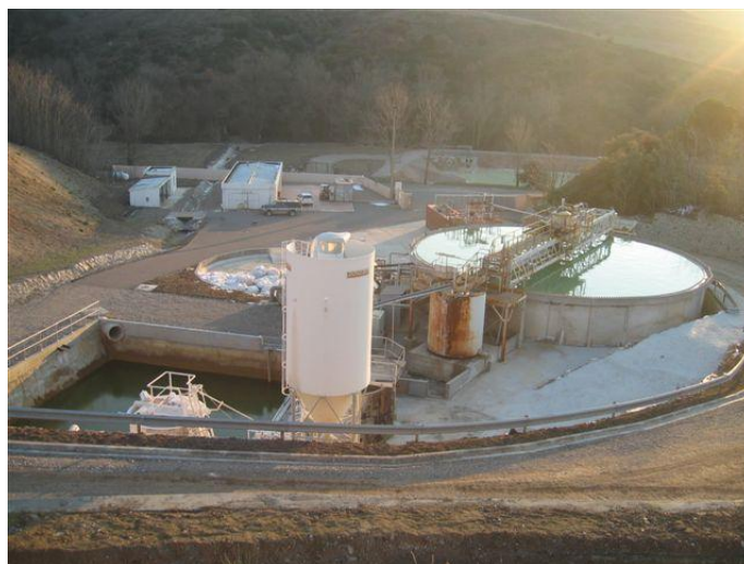
Illustration 7 - Station de traitement des eaux arséniées – Commune de Limousis (11).
