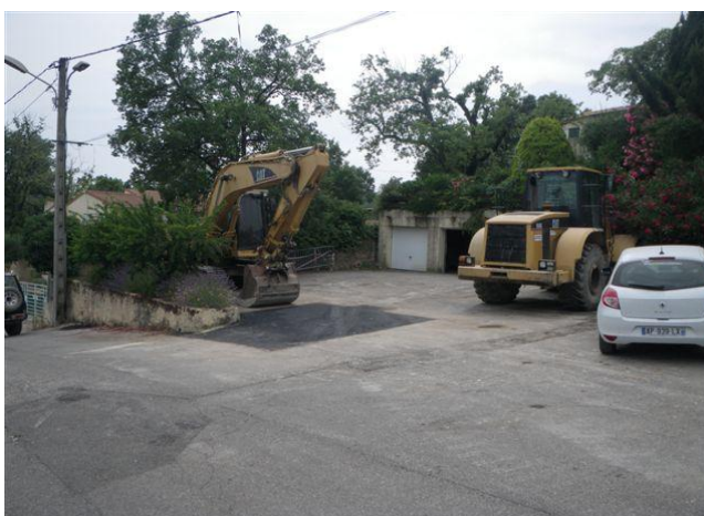
Illustration 20 - État après travaux – Commune de Connaux (30).
