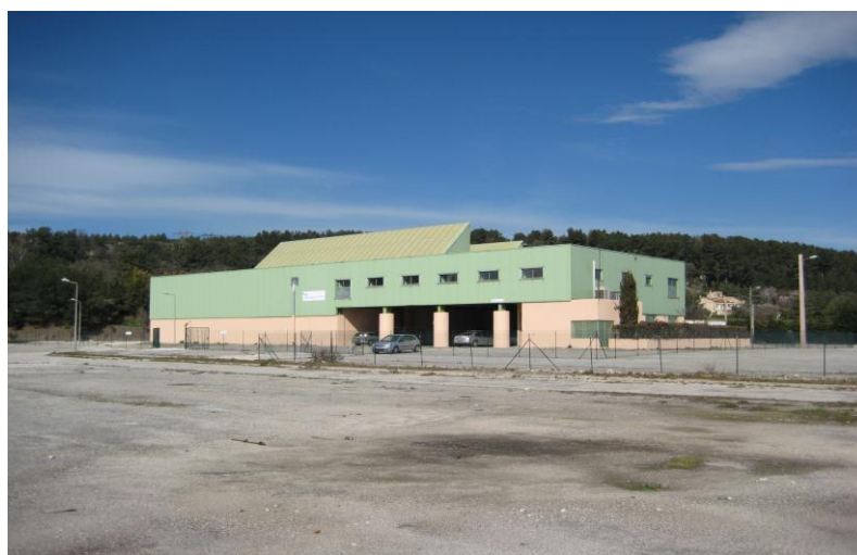
Illustration 2 - Bâtiment de l'UTAM Sud, Commune de Gardanne (13).
