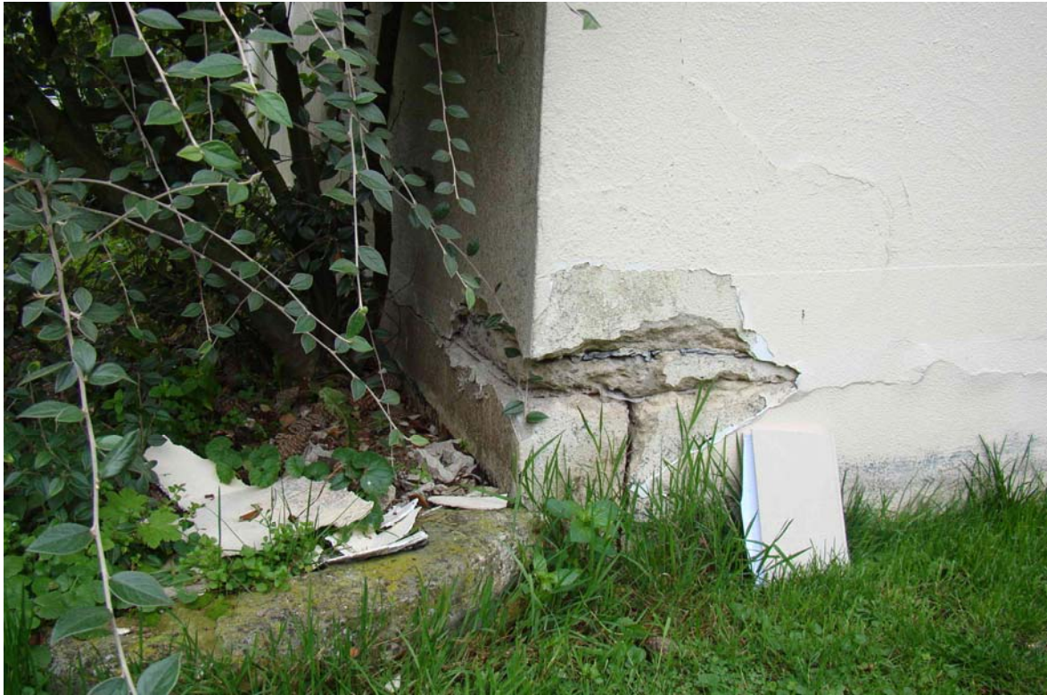
Photo 1 : Angle sud de la maison
