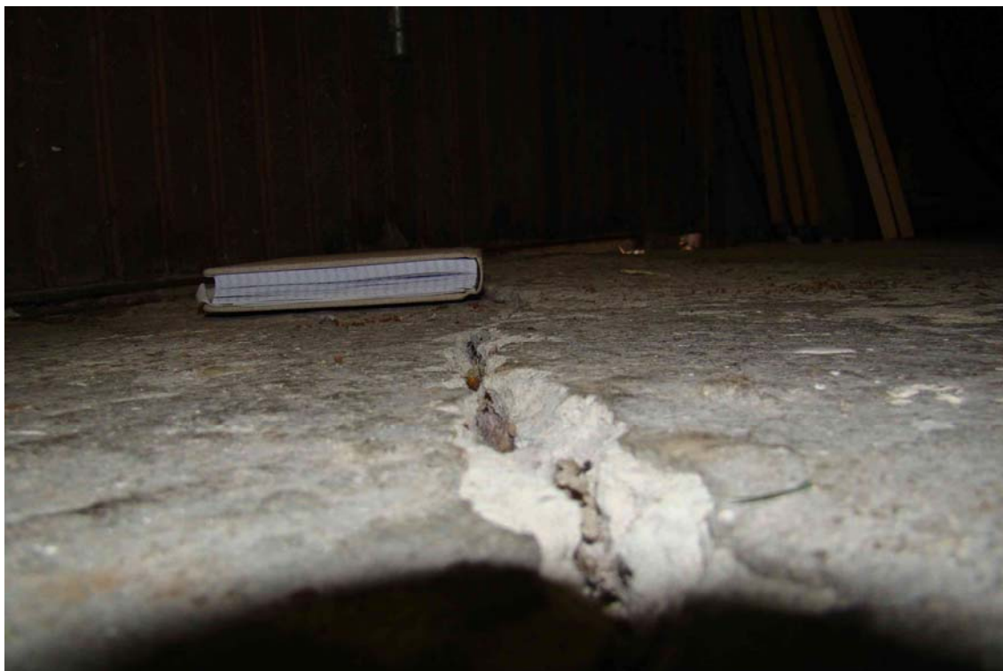
Photo 6 : Sol du garage
