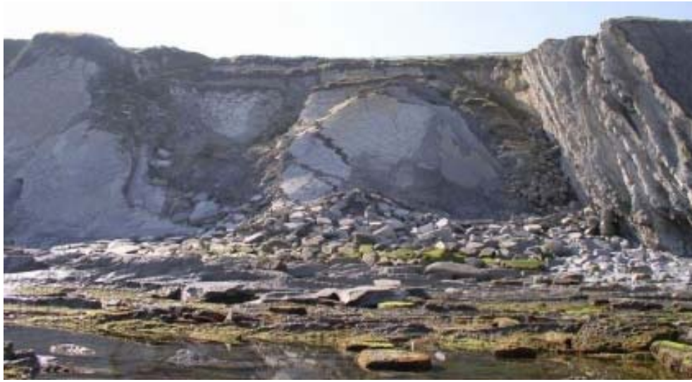
Illustration 31 : Glissement banc sur banc (Corniche Basque à Urrugne, 2006)
