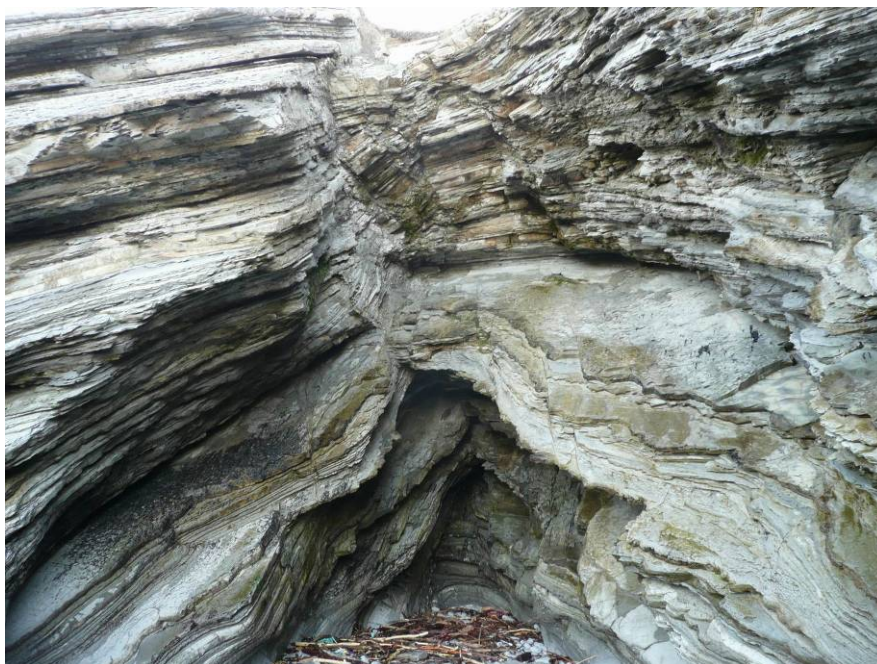
Illustration 42 : Zone fracturée et broyée située entre l'ancien sémaphore et la route de la Corniche
