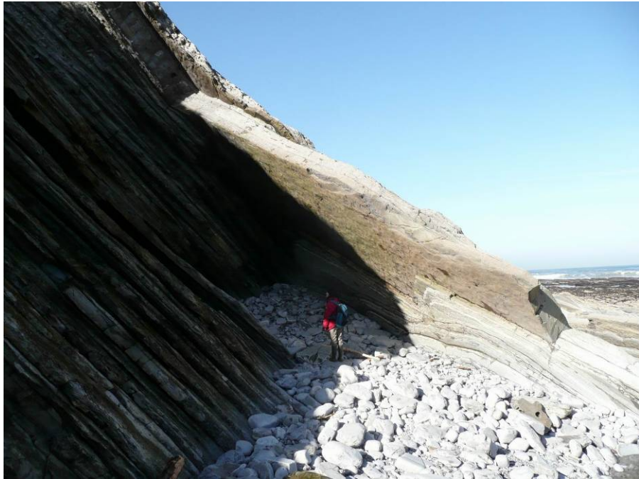
Illustration 46 : Fort sous-cavage des bancs marneux sur 10 m de profondeur
