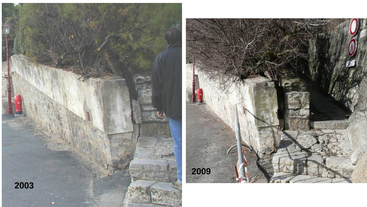
Illustration 50 : Déversement du mur du quai Passicot
