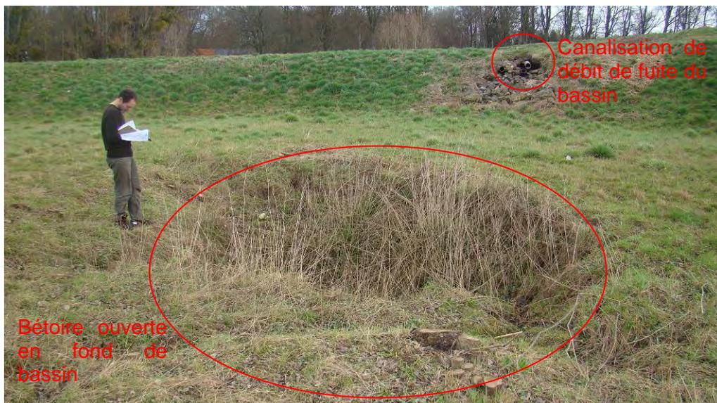
Illustration 14 : Ouverture de la bétoire dans le fond d’un ouvrage hydraulique de rétention des eaux pluviales (bassin de rétention du Val Postel – SERSAEP) – observation BRGM d’avril 2010
