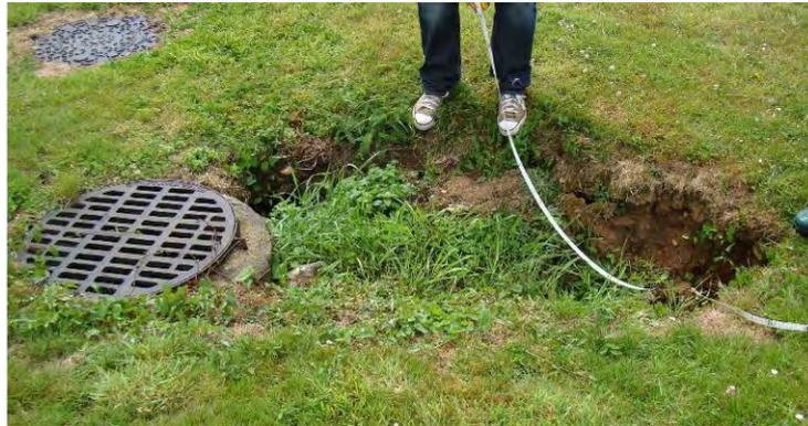
*Illustration 27 : Bétaire n°9816 aménagée par un avaloir en béton amenant les eaux de ruissellement vers le réseau d’eau pluvial. La bétaire s’est réouverte au droit de l’avaloir, photo du 17/07/09*
