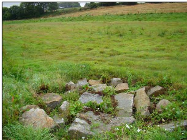
*Illustration 21 : Exemple d’un aménagement d’une bétoire par mise en place d’enrochements*
