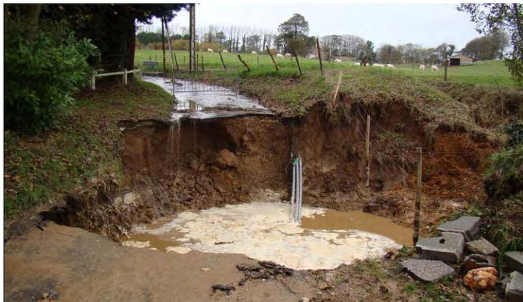
**Doline Bétoire n°10079** : effondrement du 04/11/2009 au niveau d'une route à Saint Jouin de Bruneval – diamètre de l'ordre d'une dizaine de mètres (observation BRGM du 06/11/2009) – Bétoire recevant les eaux des talwegs inondés à l'amont
