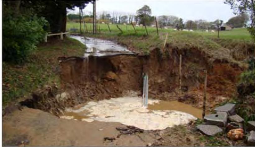
*Illustration 16 : Doline Bétoire n°10079 : effondrement du 04/11/2009 sous une route à St Jouin de Bruneval – diamètre de l’ordre d’une dizaine de mètres (observation du 06/11/2009- Bétoire recevant les eaux des talwegs inondés à l’amont)*
