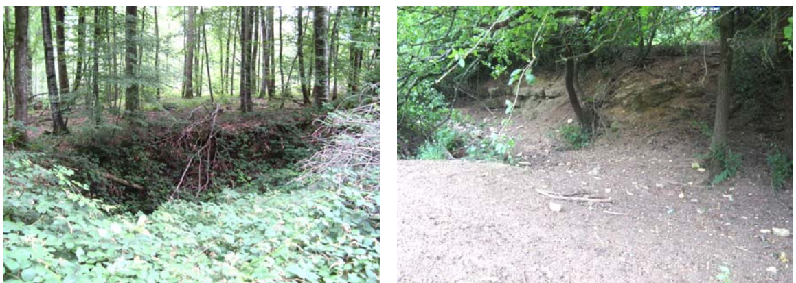
Illustration 18 : effondrements dans la Nièvre (photos BRGM).
