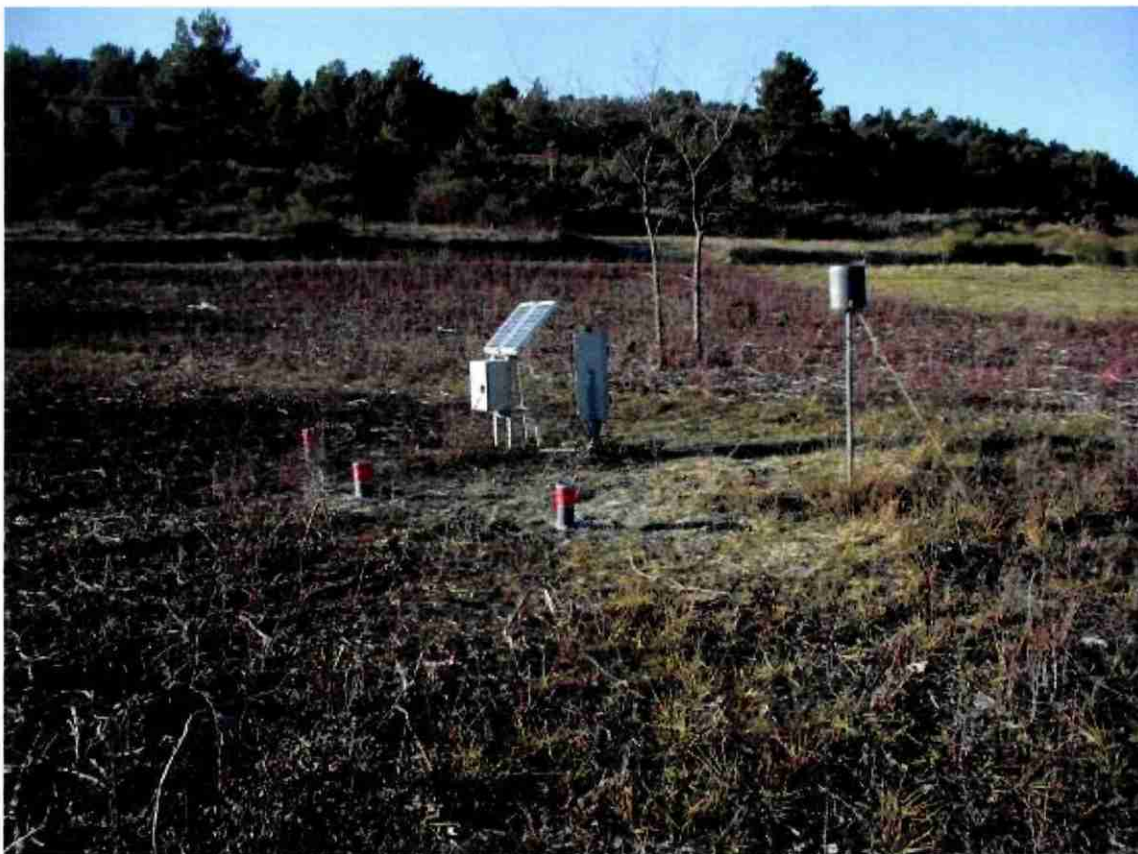
Illustration 39 – Vue d'ensemble du site instrumental de Mormoiron
