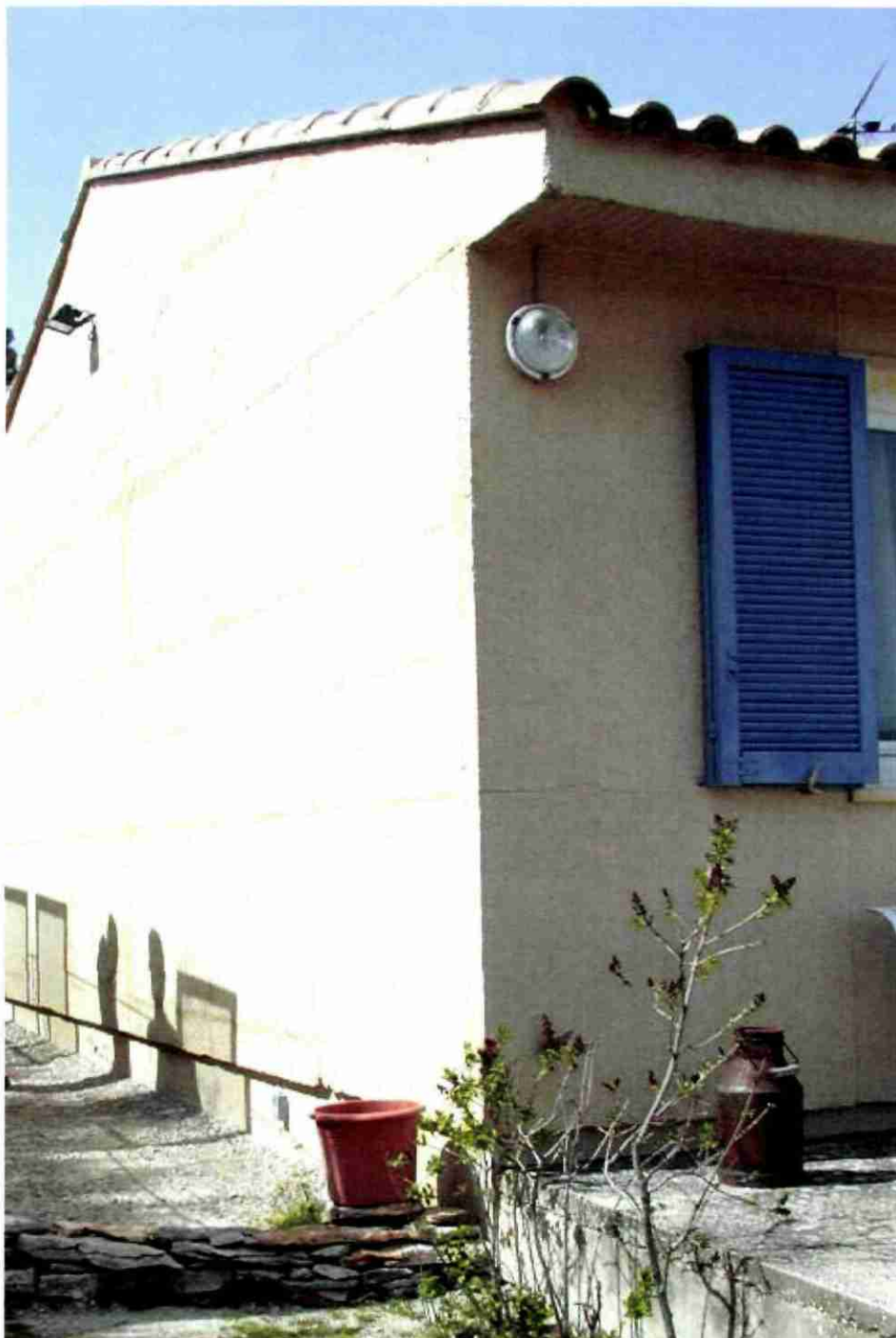
Illustration 42 – Vue de la façade sud de la maison instrumentée
