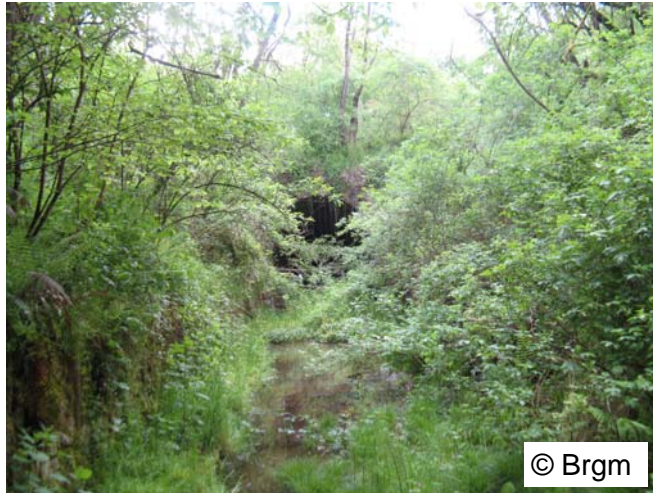
Illustration 15 : Tunnel ferroviaire abandonné (commune de Montréal).
