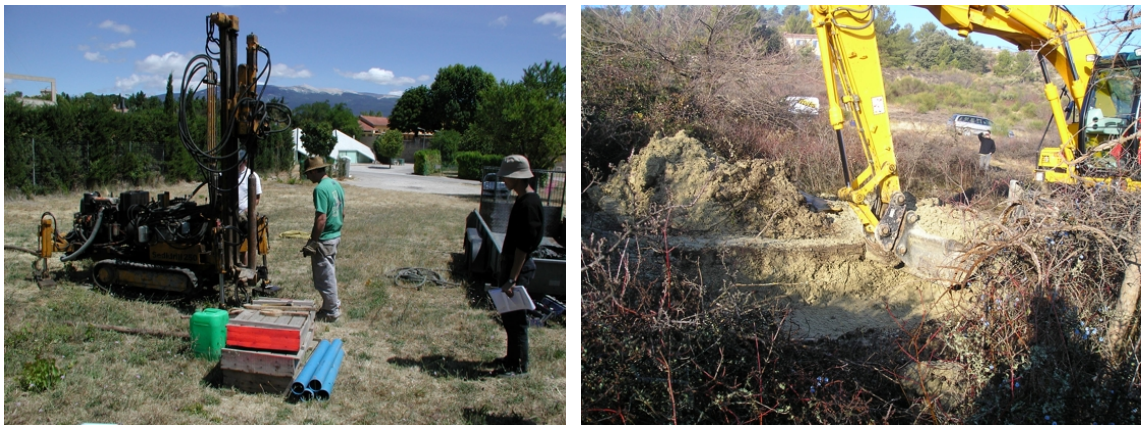
Illustration 3 – Reconnaissances par sondages carottés (à gauche) et par ouverture d'une fosse à la pelle mécanique (à droite) (BRGM)
