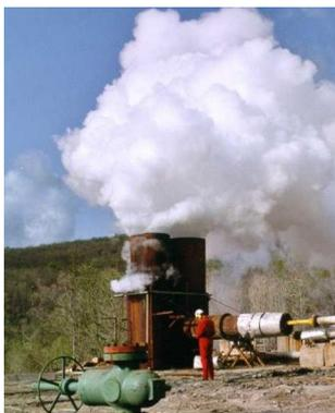
Panache de vapeur lors des essais de production des forages de Bouillante qui prélèvent le fluide géothermique à environ 1 km de profondeur sous le bourg de Bouillante (photo Géothermie Bouillante).
