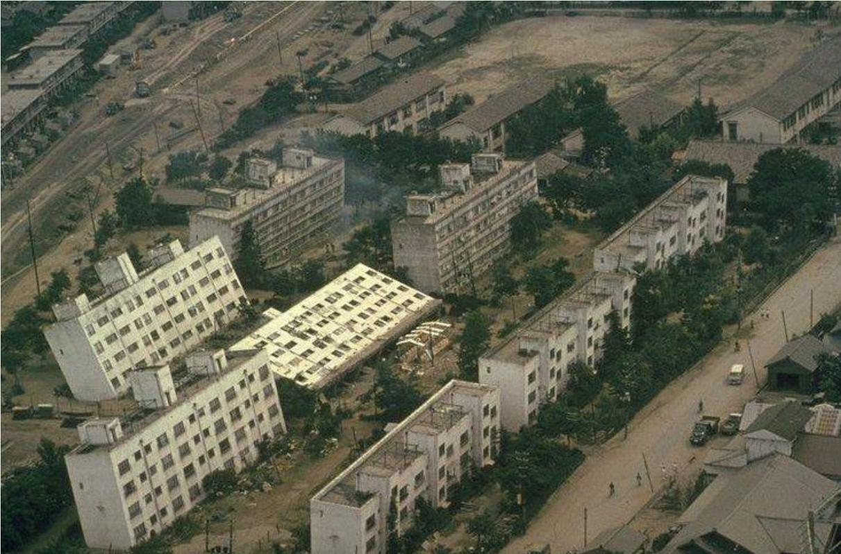
Figure 122 - Bâtiments enfoncés dans le sol à cause de la liquéfaction (Source : National Geophysical Data Center)
