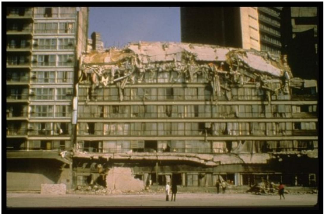
Figure 172 - Bâtiments fortement endommagés lors de séisme de Mexico en 1985 (Source : Laboratoire MSSMat, Ecole Centrale Paris, [http://www.mssmat.ecp.fr/article.php3?id\\_article=492](http://www.mssmat.ecp.fr/article.php3?id_article=492))
