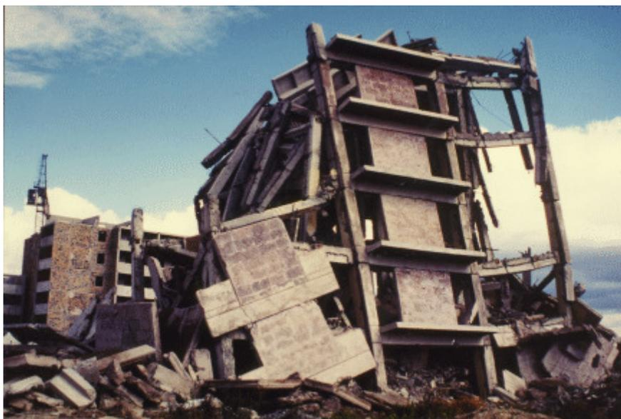
Figure 163 - Ruines d'un immeuble après le séisme de Spitak en Arménie en 1988 (Source : Compagnie Suisse de Réassurance, Zurich)
