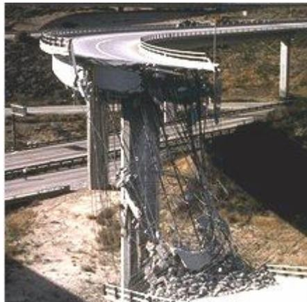
Figure 34 - Autoroute endommagée par le séisme de Northridge (Source : USGS)
