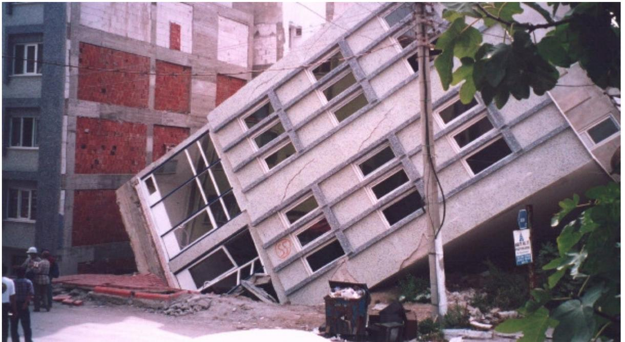
Figure 124 - Bâtiment enfoncé dans le sol à cause de la liquéfaction (Source : Rapport USGS)
