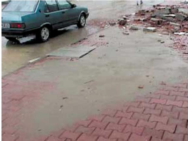
Figure 120 - Formation de cônes de sables (ou "volcans de boue") après le séisme d'Izmit
