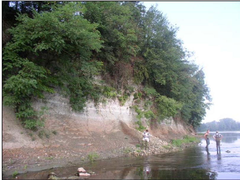
Illustration 23 - Erosion de berge à Craitilleux (n°64200042) menaçant une voie de circulation et, à moyen terme, une habitation
