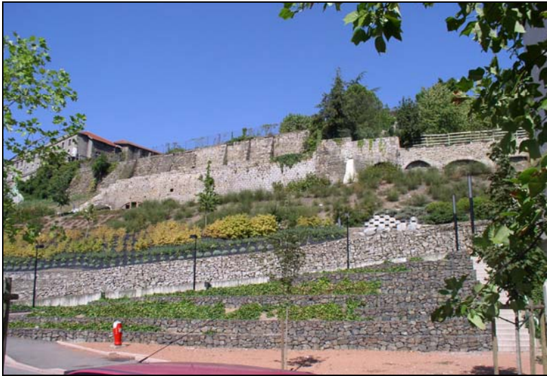
Illustration 22 - Travaux de confortement (soutènement, gabions, terrassement, drains, ancrages...) réalisés sur le glissement de la colline de Saint-Ennemond à Saint-Chamond (n°64200003)
