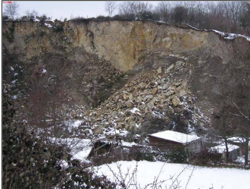
Illustration 33 - Eboulement dans une ancienne carrière à Montbrison (n°64200160)
