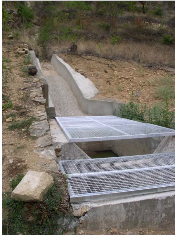
Illustration 28 - D essableur r alis  en pied de versant sur le passage d'une coul e de boue r currente   Chavanay (n 6420030)
