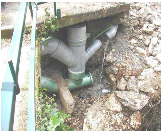
*Illustration 77 - Détail du puits de mise en charge et des deux venues de captage, au niveau de la passerelle sur le site de captage de la source des Adoux.*
