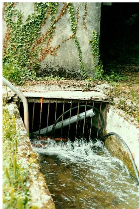
*Illustration 61 - Canal en sortie de la chambre de captage de la source du Verdoble.*
