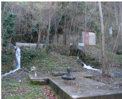
*Illustration 79 - Mise en fonctionnement de trop-pleins échappant au système de contrôle.*
