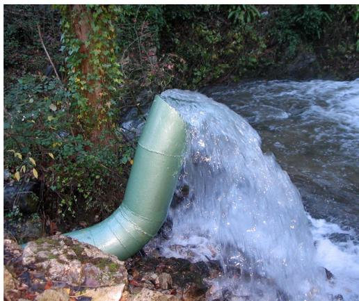
*Illustration 78 - Détail de l'exhaure du dispositif de mesure de l'essentiel des trop-pleins au niveau du captage de la source des Adoux.*
