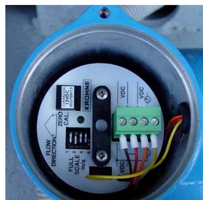
Illustration 76 - Débitmètre électromagnétique Krohne, de type DMW2000, installé sur la conduite de mesure du dispositif de captage des trop-pleins à la source des Adoux.
