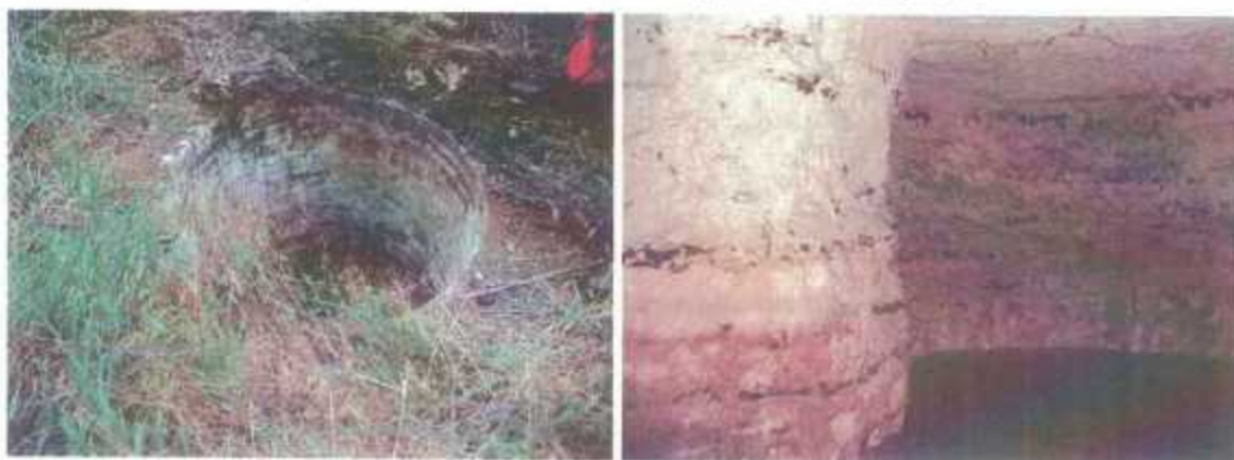
fig. 15 - A gauche : Puits d'accès à une marnière (diam. : 1 m, prof. : 30 m) ; à droite : vue intérieure d'une marnière ; région de Montargis
